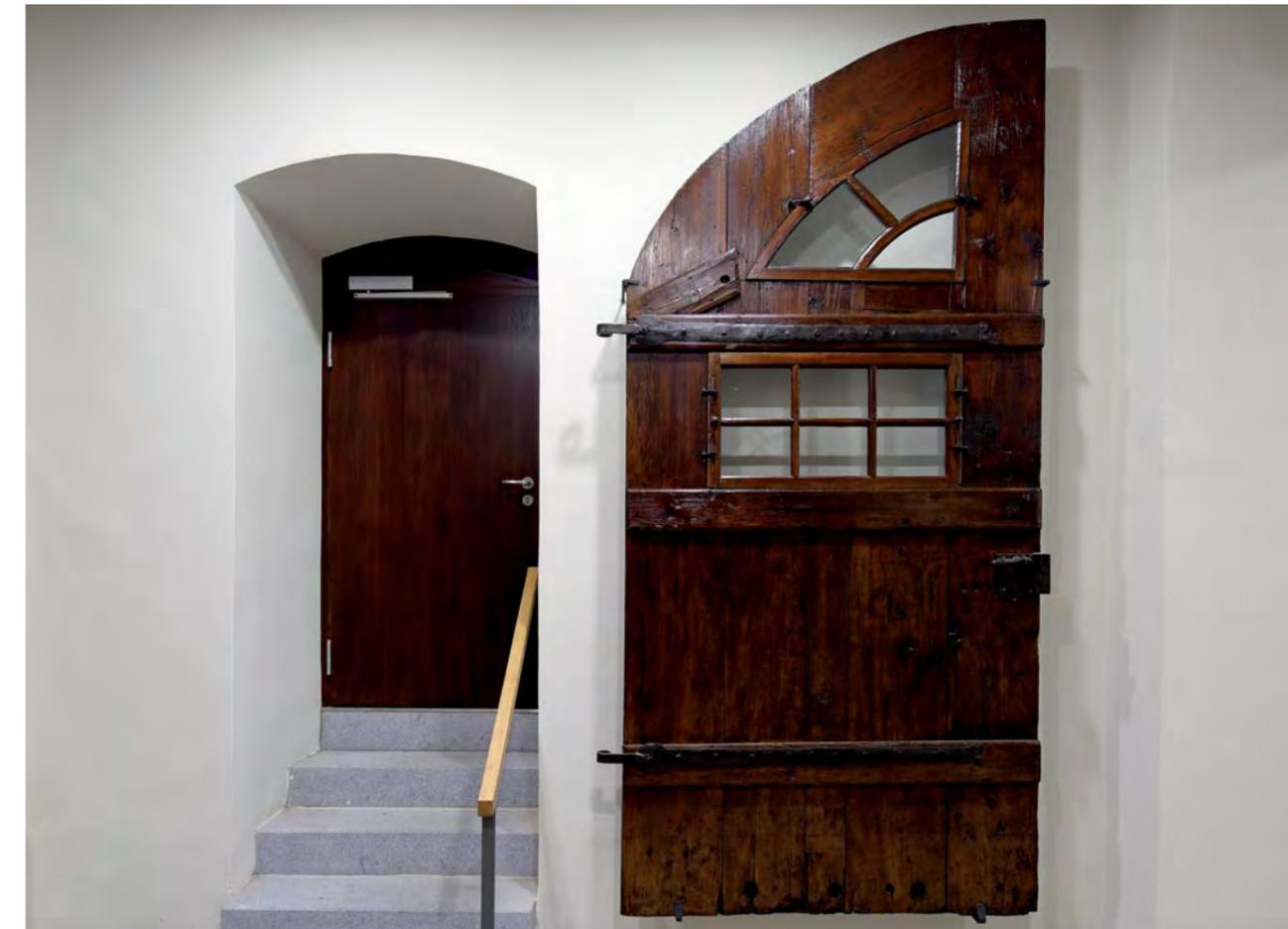
Südlicher Flügel eines zweiflügligen Tores aus der 1. Hälfte des 19. Jahrhunderts. Ursprüngliche Lage zu Werksteinbogen (dat. 1569) in der Westfassade des Ostflügels. Tannenholz, zwei ursprüngliche Fassungen erhalten. Reinigung, Konservierung und Ergänzung 2014. Hängung museal in der Einfahrt zum Westflügel
