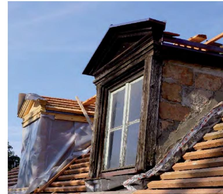
Ostdachfläche, südlich rekonstruierte Gaube, nördlich originale Gaube um 1805 mit Gaubenspiegel in Ziegelmauerwerk und in diesem Fall darauf zu erneuernder Verputzung
