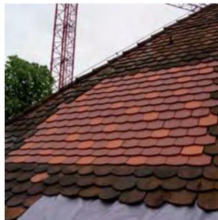
Musterfläche zur Dacheindeckung mit Segmentschnittziegeln
