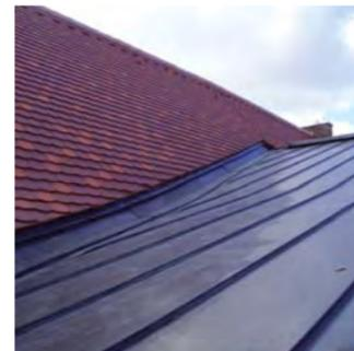
Einschnitt des verblechten Satteldaches des Portikus in die Ziegeldachfläche Nord
