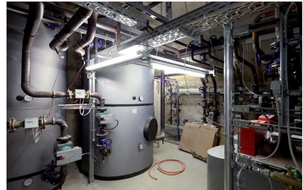
Gespeicherte Energie aus Abwasser im Kälte- bzw. Wärmespeicher
