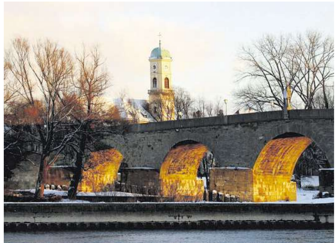
Auch nach der Sanierung werden weder Autos noch Busse über die Steinerne Brücke rollen
