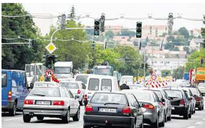
Damit der Verkehr auch während der Bauzeit rollen kann, wurden an der Nordgaustraße provisorische Überspannungen für die Ampeln angebracht
