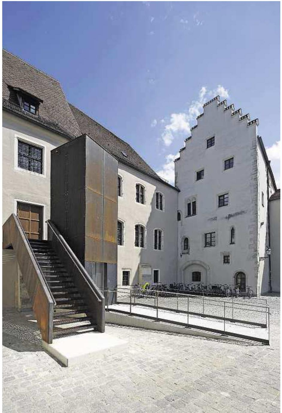
Steigung von 7,5 Prozent – die DIN 18040 schreibt Steigungen bis sechs Prozent vor. Im Gebäude selbst gibt es weitere Niveaunterschiede, die überwunden werden müssen. Hierbei helfen eine festeingebaute Rampe sowie mobile Keile.
