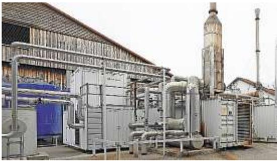
→ Das erzeugte Biogas wird im Blockheizkraftwerk in Strom und Wärme umgewandelt
