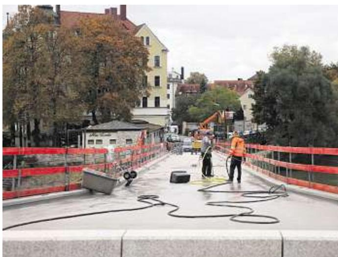
→ Die neue Fahrbahnplatte besteht aus Beton
