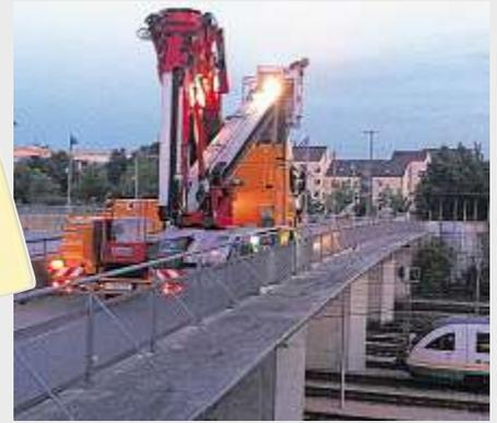
→ Brückenprüfung auf der Kumpfmühler Brücke mit einem sogenannten Brückenuntersichtsgerät. Foto: Tiefbauamt, Nicklas
