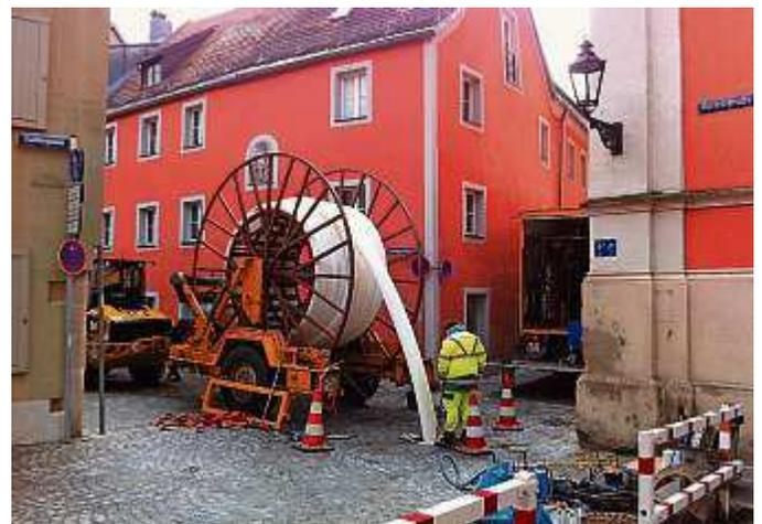
→ Beim Close-Fit-Verfahren wird über den Kanalschacht ein Schlauch eingebracht, der den Kanal abdichtet. Foto: Tiefbauamt, Petra Ponkrat
