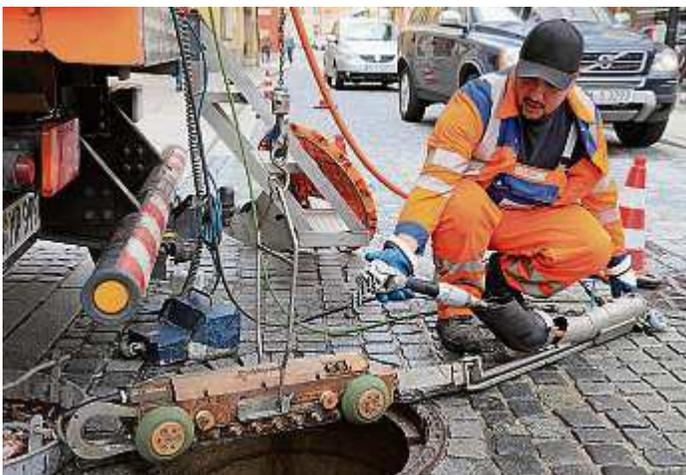
→ Mit einer Kamera, die Bilder in einen Übertragungswagen sendet, werden die Kanäle systematisch untersucht.
