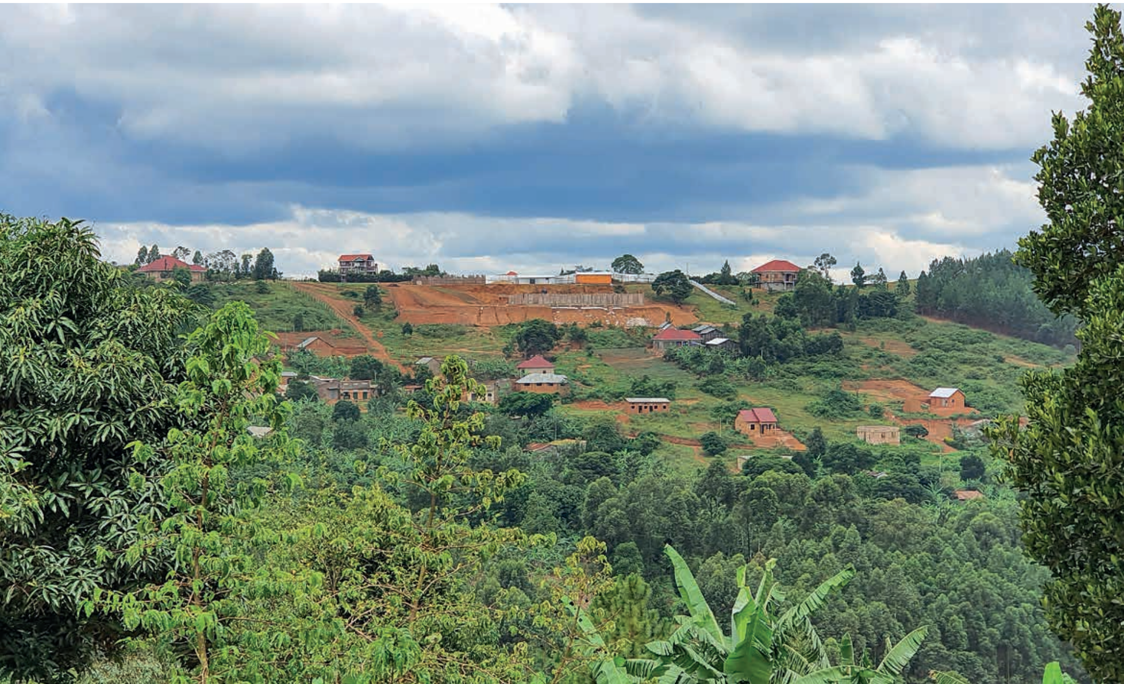
Landschaft mit Ausblick zur Baustelle der neuen Musikschule
