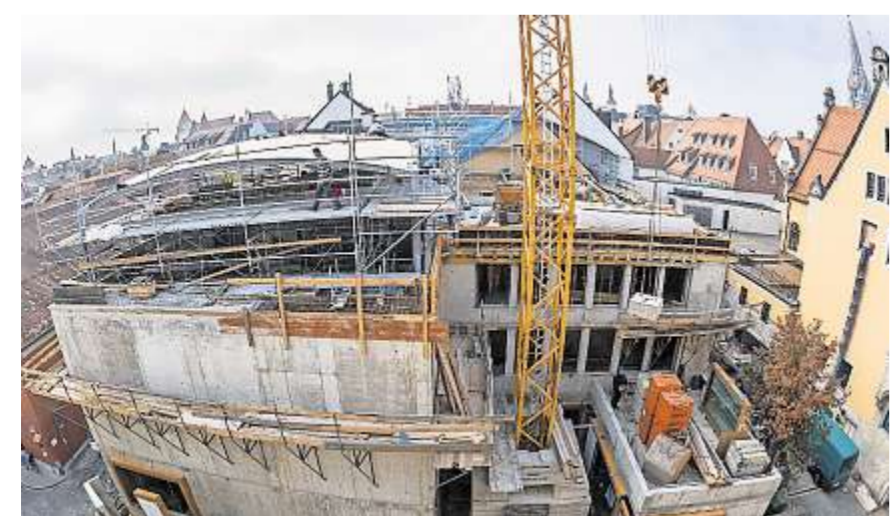
Die Baustelle der Synagoge im Oktober 2017, kurz vor dem Richtfest: Fast 80 Jahre nach der Zerstörung ihrer Synagoge durch die Nationalsozialisten erhält die Jüdische Gemeinde ein neues Gebetshaus. FOTO: ARMIN WEIGEL/DPA
