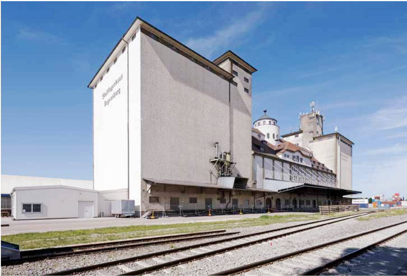
Blick auf das Stadtlagerhaus von Südwesten
