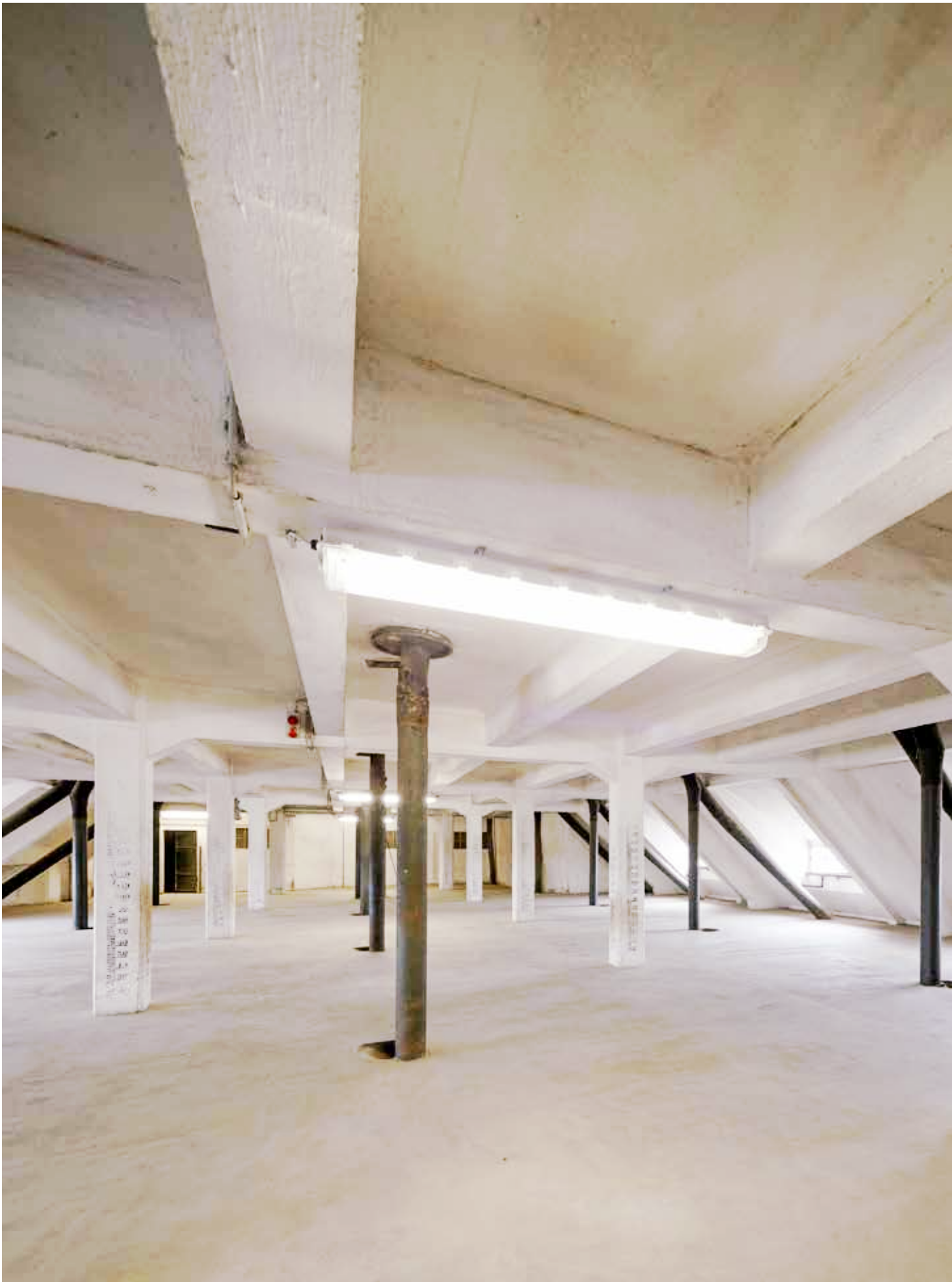
Lagerboden im fünften OG Mitteltrakt
