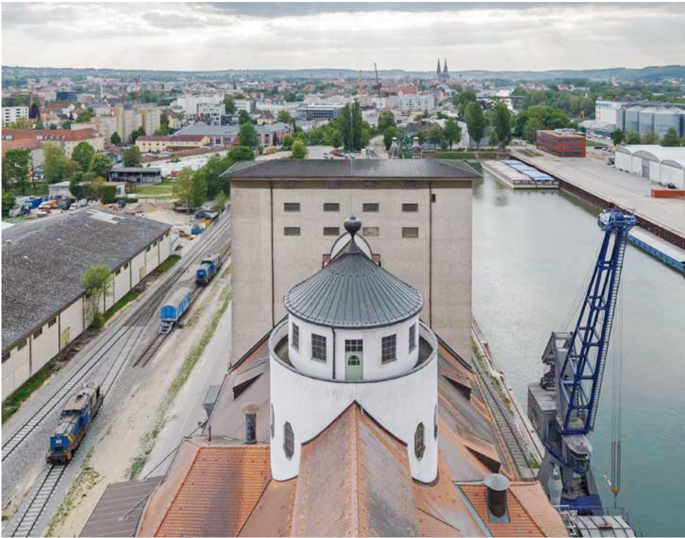
Blick vom Dach des Silo Ost
