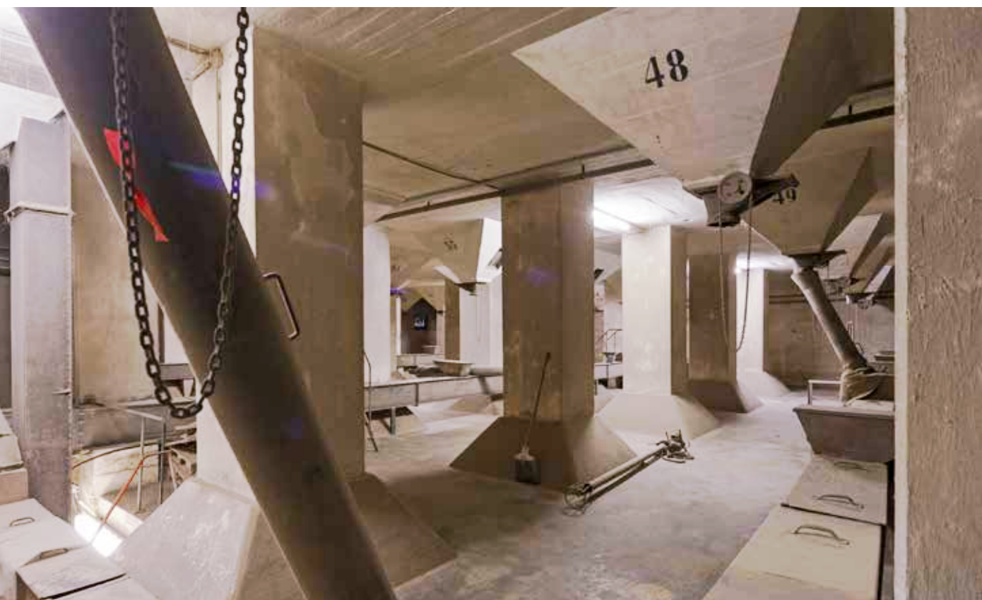
Keller im Silo Ost
