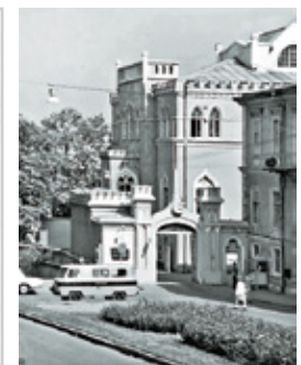
Palast von I. Witt, Lanzheronovskaya-Straße, 1848 umgebaut (Architekt Franz Boffo). Das Gebäude beherbergte das Büro der ROPIT-Leitung. / Палац І. Вітта, вул. Ланжеронівська, перебудований 1848 року (архітектор Франц Боффо). У будівлі розміщувався Управління РОПІТ. / I. Witt's Palace, Lanzheronovska Street, rebuilt in 1848 (architect Franz Boffo). The building housed ROPIT administration.
