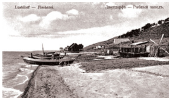
Fischfabrik an der Lustdorfer Küste Рибний завод на Люстдорфському узбережжі Fish factory on the Lustdorf coast
