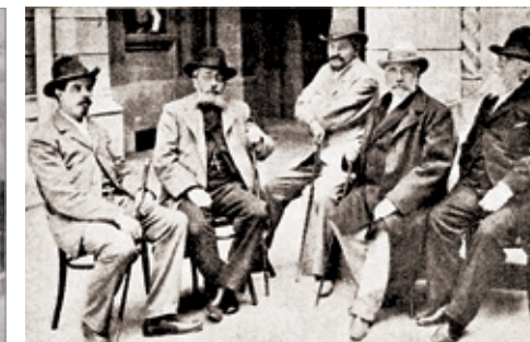
Bauauftrag für den Bau eines neuen Börsengebäudes Будівельна комісія зі спорудження нової біржової будівлі Construction commission for the construction of new stock exchange building
