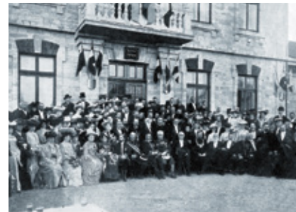
Katholisches Armenhaus am Frantsuzky Boulevard. Католицька богадельня на Французькому бульварі. Catholic almshouse on Frantsuzky Boulevard
