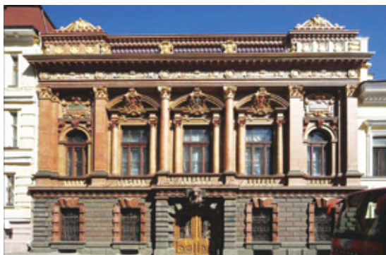
Haus der Wissenschaftler. G. Helmer und F. Felmer — Projekt. G. Chevrembrand — Bau Будинок вчених. Г. Гельмер та Ф. Фельмер — проект. Г. Шеврембранд — будівництво House of Scientists. G. Helmer and F. Felmer — project. G. Chevrembrand — construction
