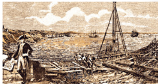
Hafen, Beginn des Hafenbaus. Гавань. Початок будівництва порту. Harbor, Beginning of the port construction.
