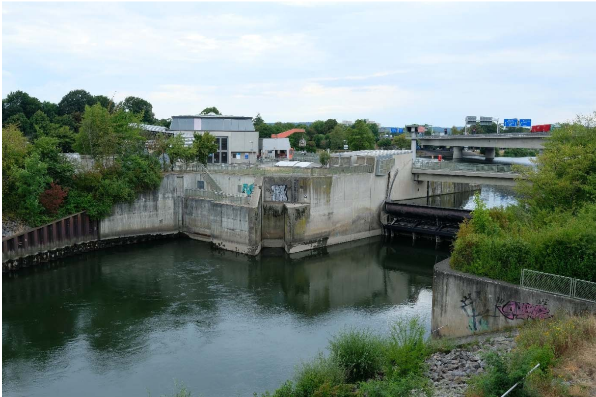
Abbildung 10: Triebwerk am Pfaffensteiner Wehr mit Blick von Norden auf den Oberen Wöhrd (Foto: Dominik Hochhäusler, 31.07.2022)
