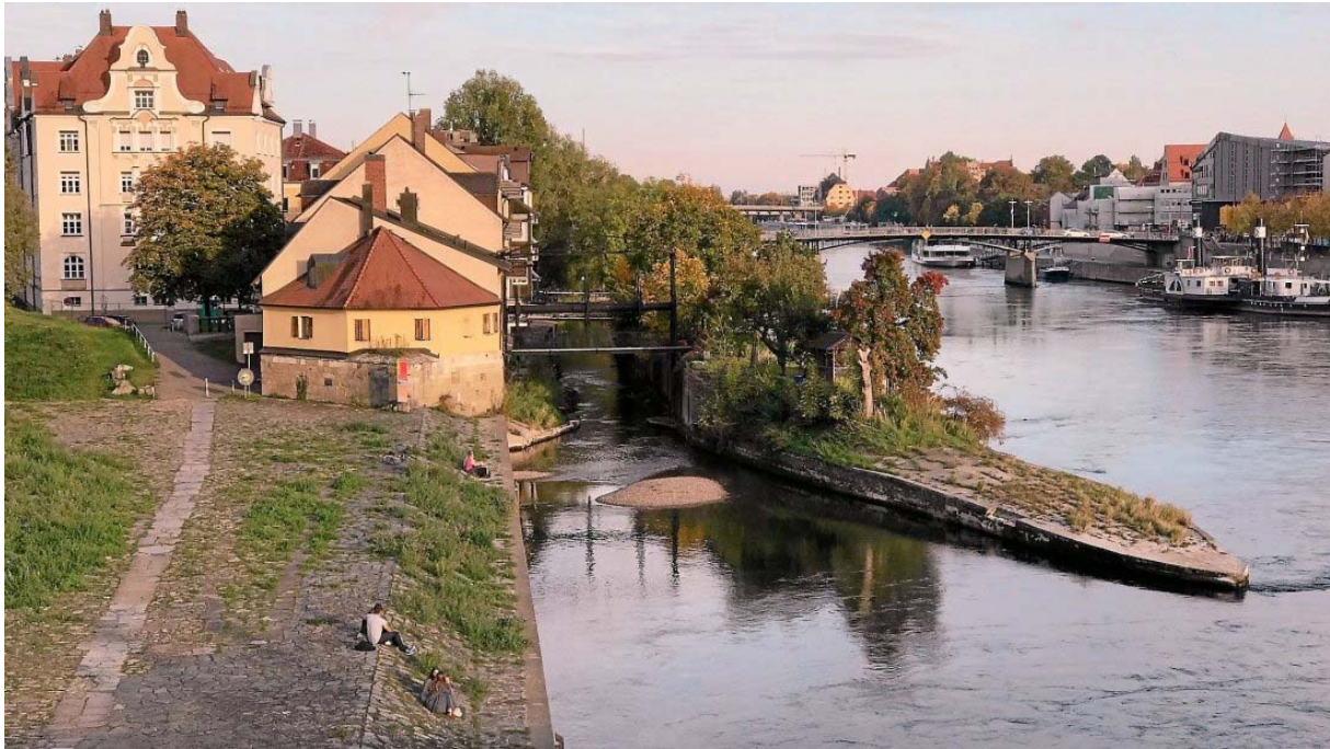
Abbildung 16: Mühlenarm, Blick stromabwärts auf die Eiserne Brücke (WSA und Stadt Regensburg, 2017)
