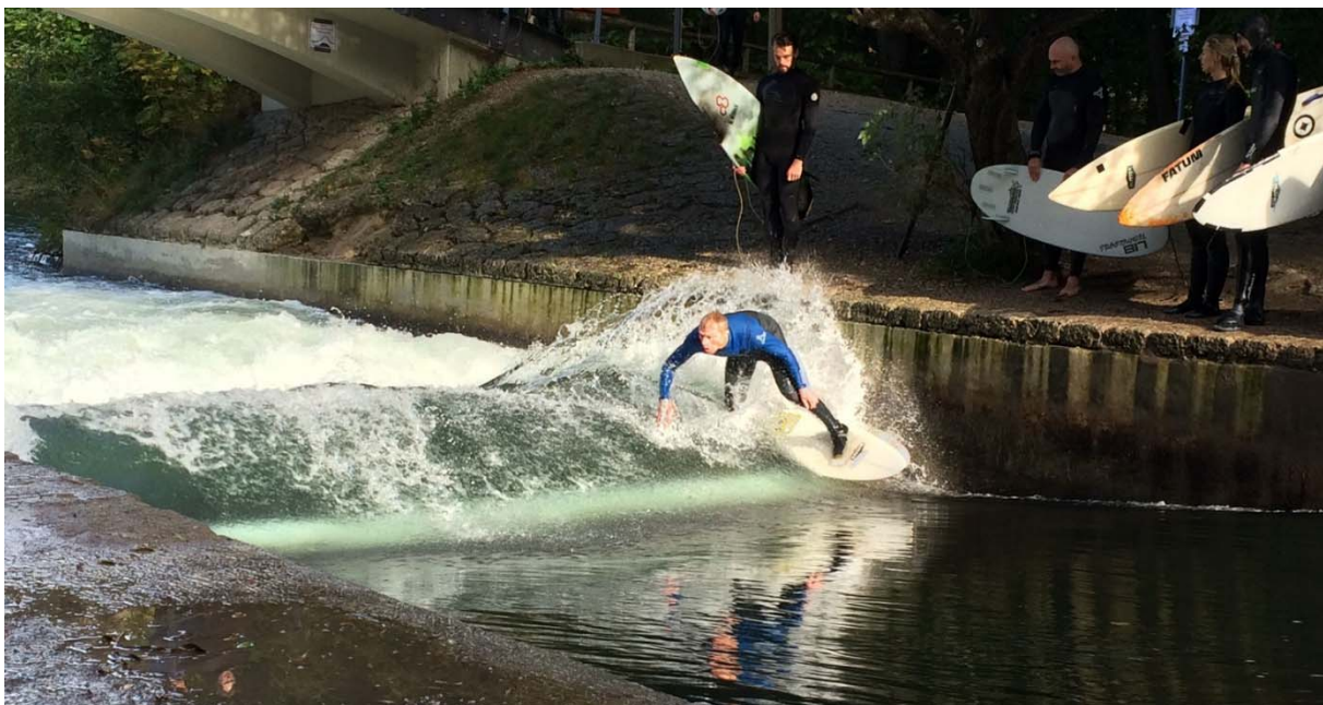
Abbildung 4: Floßlande in München nach Einbau der Technologie durch das Riverwave Project. Die Welle wird durch die – im Bild sichtbaren – unter Wasser montierten weißen Kunststoffplatten erzeugt.
