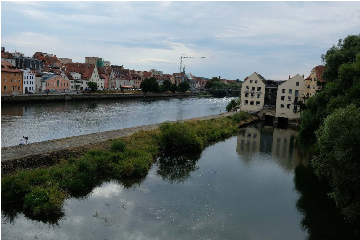
Abbildung 13: Brandner Kanal am Sorat Hotel bei der Ortsbesichtigung am 31.07.2022
