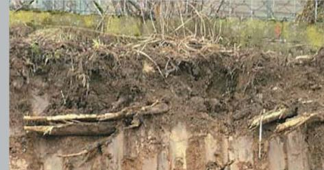
Wurzelschäden können auch nach Jahren noch zu gravierenden Stand- und Bruchsicherheitsrisiken führen. Abgerissene und gesplitterte Wurzeln führen zu Fäulnis und Statikproblemen.
