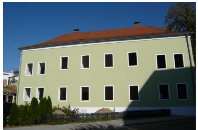
Anwesen Lieblstraße 39 während des Abbruchs. Foto: L. Beer, 2018
