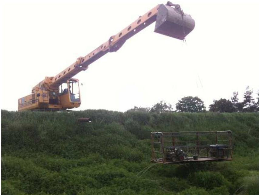
Abb. 3: Baggergeführte Bohrplattform für Erkundung der Kassetten 13 und 15
