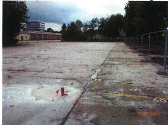
FB 12 (rechts), Blick nach SW Richtung Geb. 4
