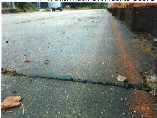
F 1, Blick nach SW, rechts Geb. 9
