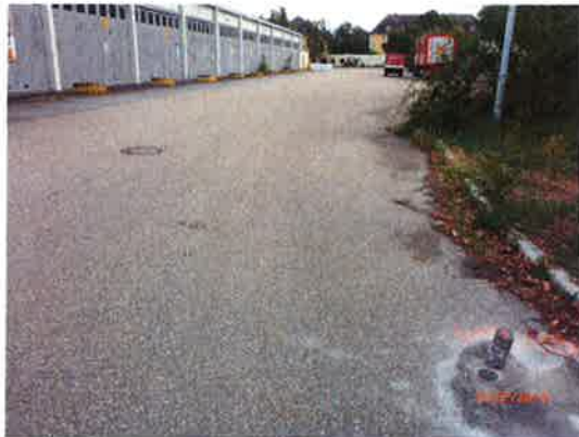
FB 10, Blick nach SE, links Geb. 2
