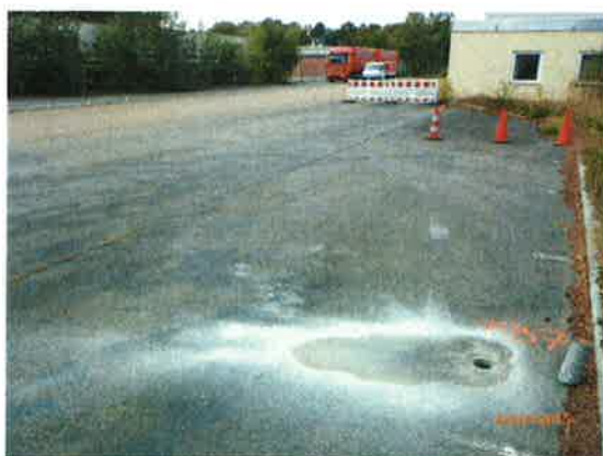
FB 7 im Hintergrund, Blick nach NW
