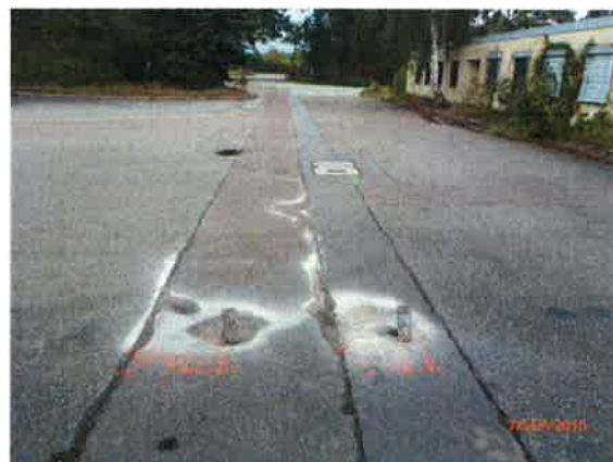
FB 5 (rechts), FB 6, Blick nach NE, rechts Geb. 1
