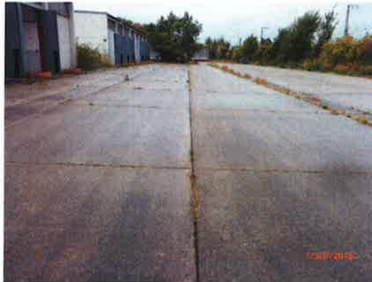
F 2, Blick nach NW, rechts Geb. 8
