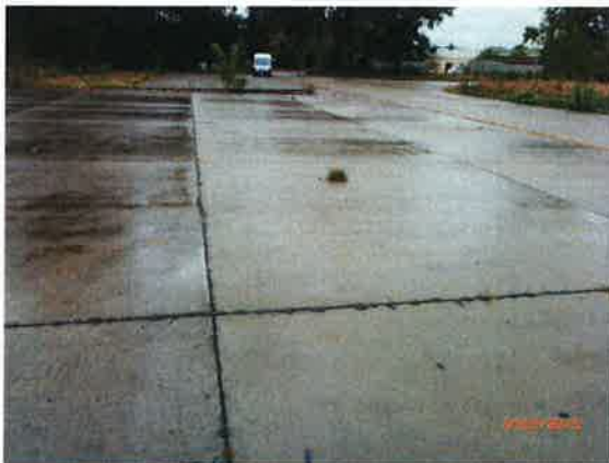
F 3, ehem. Unterstellhalle, Blick nach W
