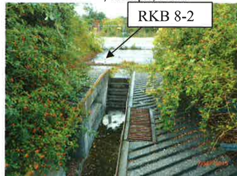
KVF 8, Rampe, Blick nach NE
