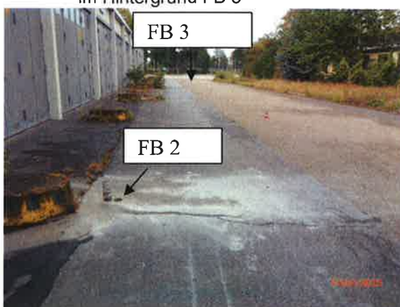
FB 2, Blick nach NW, links Geb. 2, im Hintergrund FB 3
