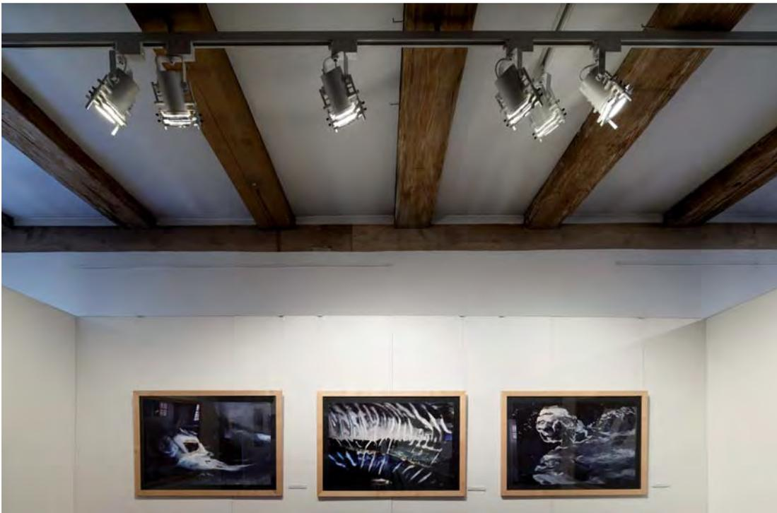
*Galerie Leerer Beutel, Ausstellungsbeleuchtung im Bestand mit herkömmlicher Niedervolthalogen-Lichttechnik, Strahler einzeln dimmbar, elektrische Leistung 50 Watt mit vorgesetzten Filtern für ultraviolettes Licht und optischen Linsen*
