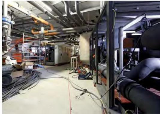
Einbringung der Wärmepumpen in Einzelteilen
