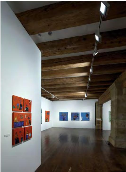
*Galerie Leerer Beutel, Wechselausstellung im 1. Obergeschoss, Stromschienen mit LED-Strahler, elektrische Leistung 24 Watt, Lichtstrom 2400 Lumen, Lichtfarbtemperatur 3000 Kelvin, einzeln dimmbar, Linse „wallwash“*
