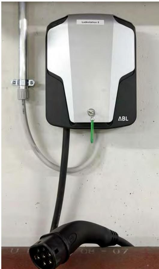
Die Schnellladeeinrichtungen ermöglichen es, die Batterien bis zu zehnfach schneller aufzuladen als an einer normalen 230 Volt-Wechselstrom-Steckdose. D. h., dass je nach Ladeleistung der Schnellladeeinrichtung und Batteriegröße des Elektrofahrzeugs der Ladevorgang auf unter vier Stunden verkürzt werden kann. Die Aufladung der Batterien erfolgt dabei zu 100 Prozent mit Ökostrom, d.h. die städtischen Elektrofahrzeuge fahren somit „CO<sub>2</sub>-neutral“.
