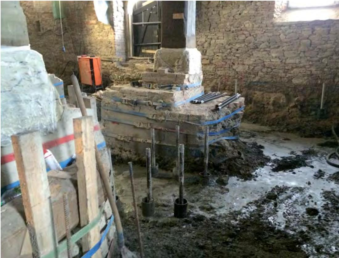
*Saniertes Stützfundament mit Kopfbewehrung der Mikrobohrpfähle*
