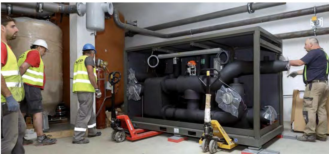
Aufstellen der Wärmepumpe (Teil 1 von 4)
