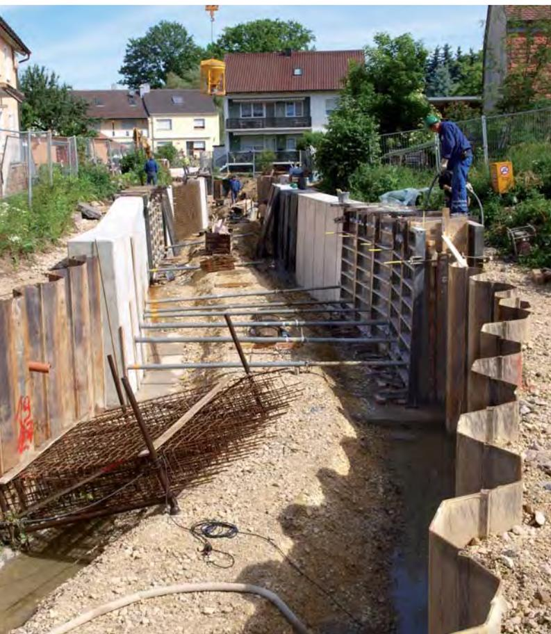
Bau des Rechteckgerinnes mit Betonverkleidung im Ortsbereich Foto: Tiefbauamt
