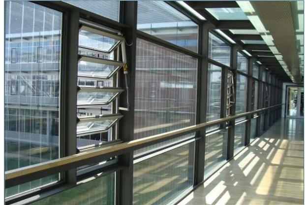
Abb. 24: Das Streifenmuster ist nur bei schräg stehender Sonne zu erkennen und passt zur filigranen Architektur des Gebäudes.
