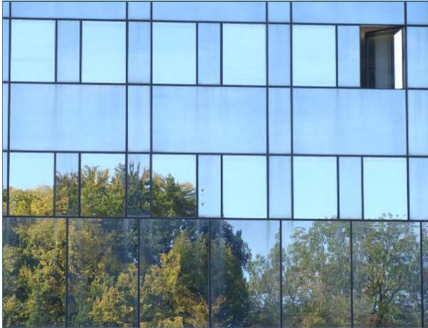
Abb. 3: Extrem spiegelnde Fassaden gelten als repräsentativ. Für Vögel sind sie eine Gefahr, denn sie täuschen eine freie Flugbahn vor.
