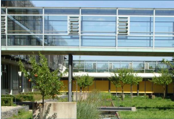
Abb. 21: Die verglasten Übergänge in den Innenhöfen des LfU in Augsburg sind für fliegende Vögel nicht als Hindernis zu erkennen. Hier kam der Birdpen zum Einsatz.
