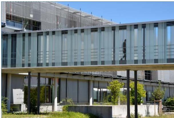
Abb. 25: Der neue Übergang aus halbtransparenten bzw. matten Scheiben bietet Sicherheit für vorbeifliegende Vögel ...
