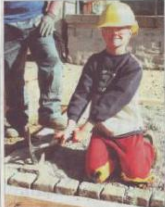
Plasterarbeiten verfolgen, das konnten die Kinder nach kurzer Zeit schon recht gut selber machen.
