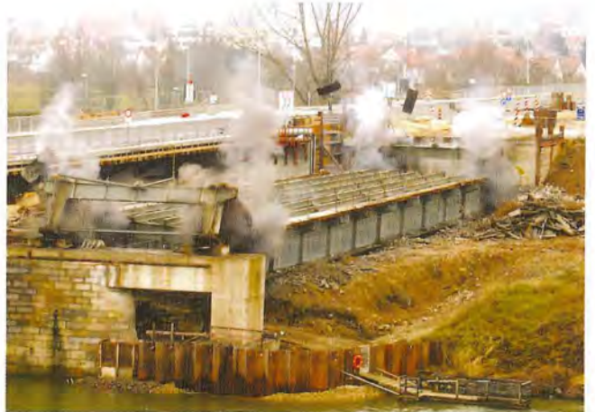
Sprengung eines Vorlandfeldes
