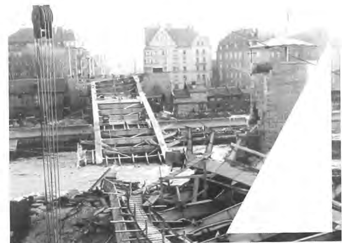
Zerstörung 1945 - Gesprengte Südbrücke
