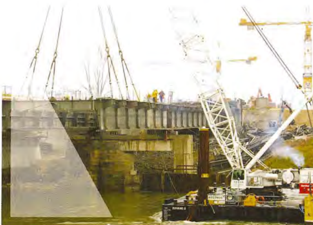
Ausheben der Stahlkonstruktion mit Schwimmkran
