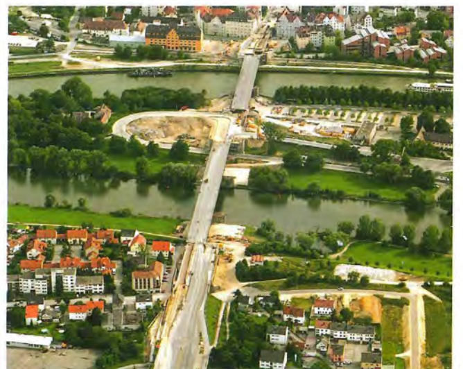
Nordbrücke verschoben, Südbrücke noch nicht
