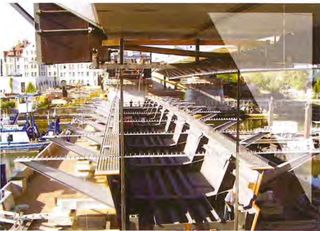
Stahlkonstruktion für Flussfeld auf Schiffsponton
