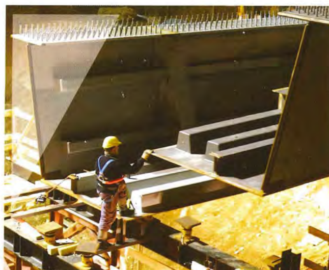
Auflegen und Einpassen der Stahlbauteile auf Montagegestütze
