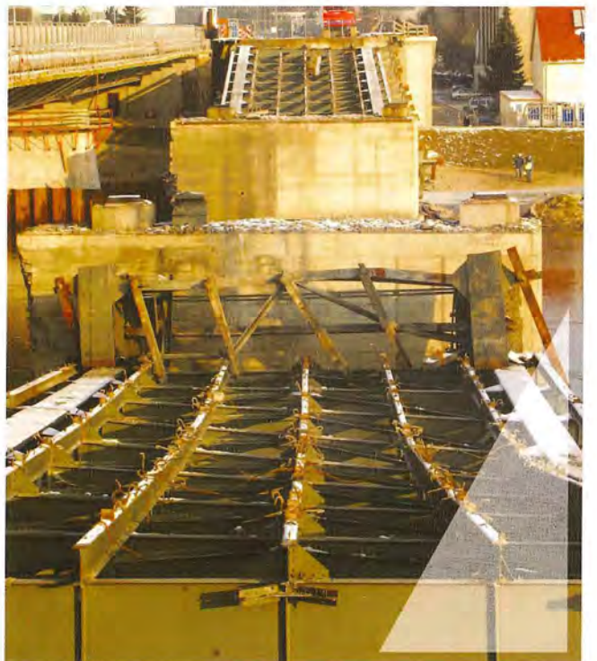
Gesprengte Vorlandfelder der Nordbrücke
