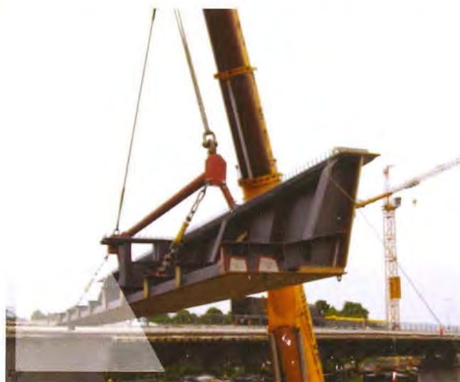
Einheben eines Stahlelementes bei Tag
