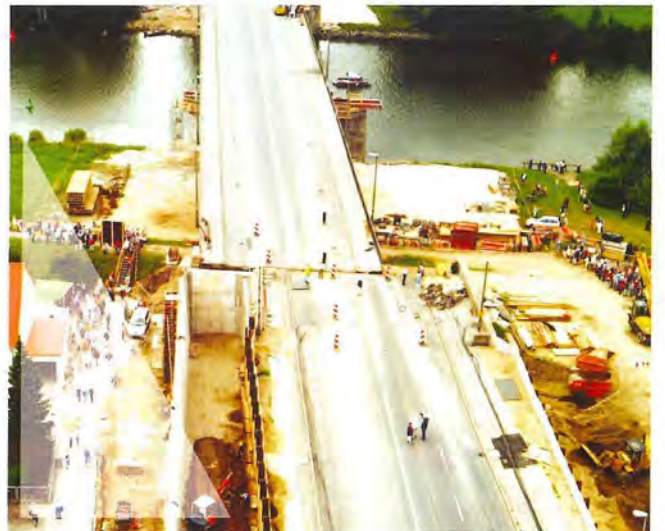
Verschub Nordbrücke 8. August 2001
