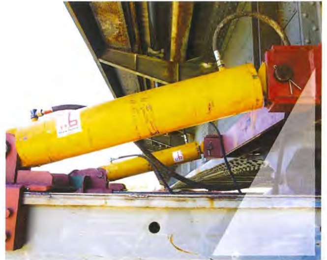
Verschubpressen auf Verschubbahn
