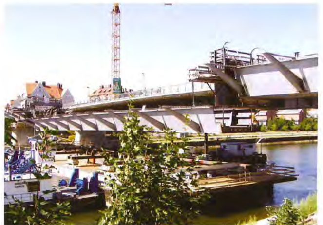
Hochziehen der Stahlkonstruktion vom Schiff
