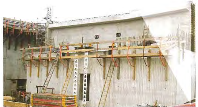
Kastenwiderlager für den Überbau
