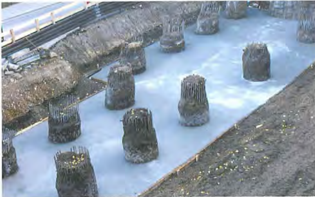
Pfahlgründung mit Großbohrpfählen
