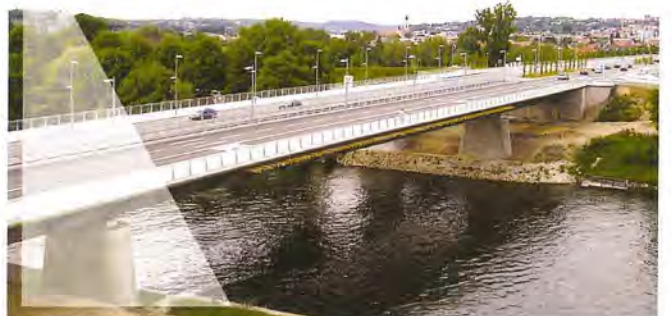
Fertiggestellte neue Nibelungenbrücke
