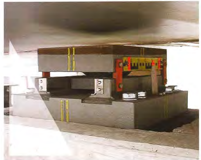
Ein Brückenlager
