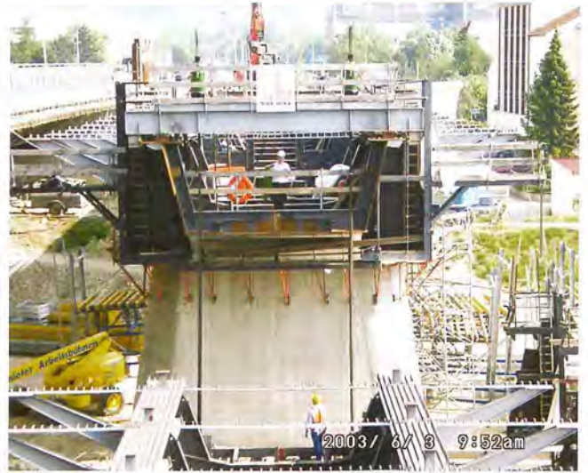
Hebevorrichtung mit Stahlseilen
