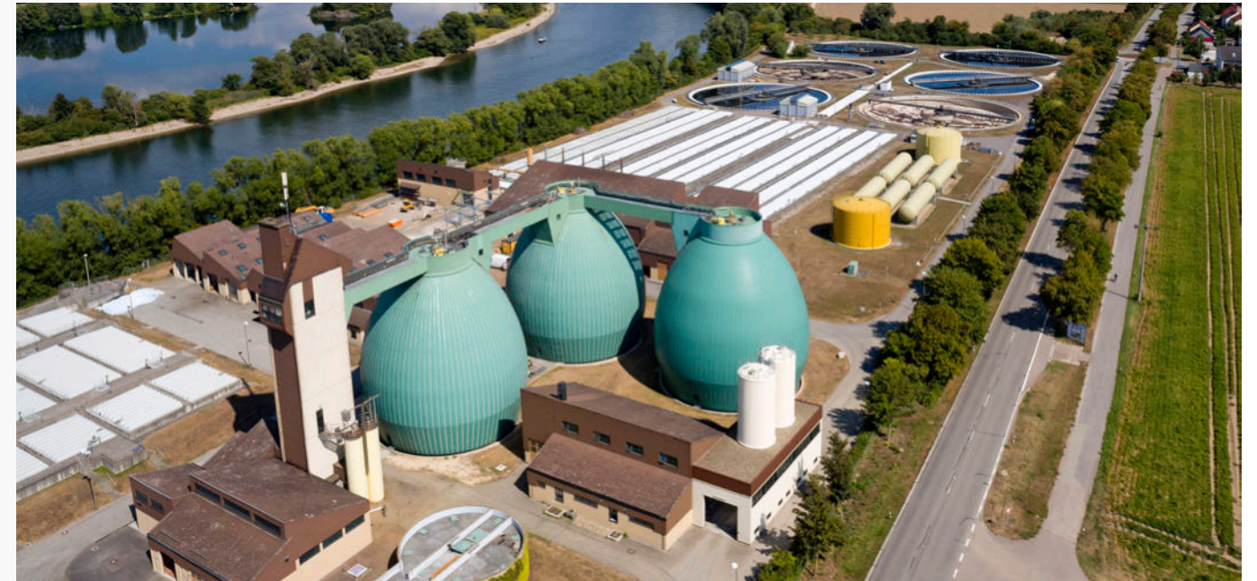
Das Klärwerk Regensburg.
