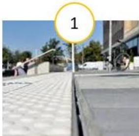
1. Entwässerungsrinnen und Regenrückhaltebecken
