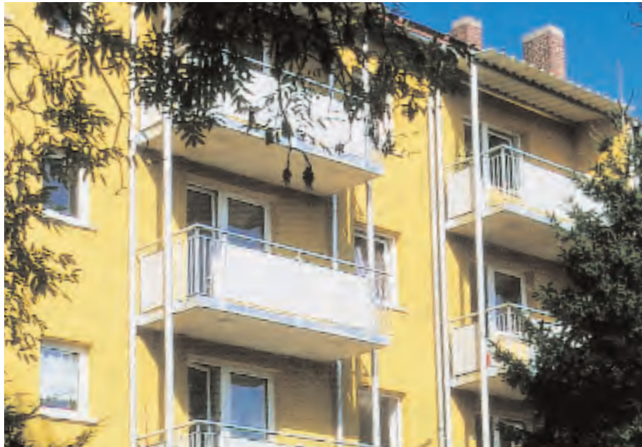
Neue Balkonanlage Humboldtstraße 29
