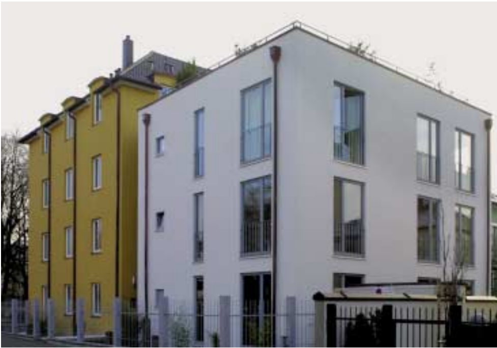
Prebrunnstraße, Ansicht von Nordwesten
