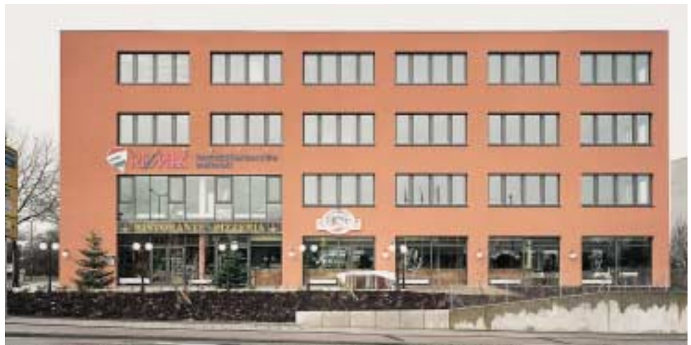
Lilienthalstraße/Prüfeninger Schloßstraße, Ansicht von Osten
