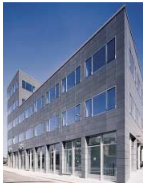
Ansicht von Süd-Westen, Fassade
