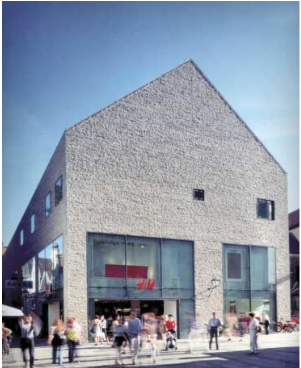
Ansicht von Norden, Fassade, Endfassung
