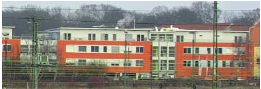
Ansicht von Süden, Fassade, Endfassung
