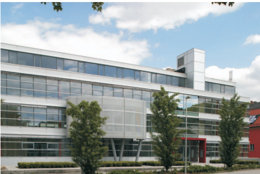
Galgenbergstraße 2a ("Posthof") - Ansicht von Westen
