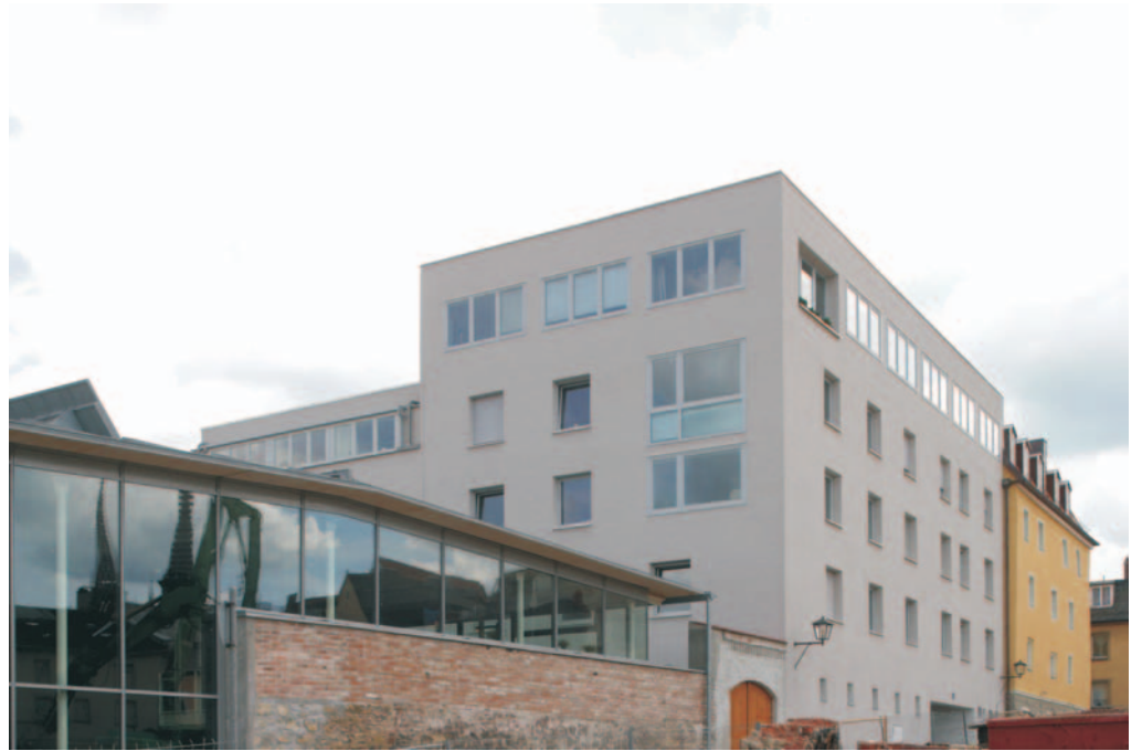
Gichtlgasse 3 - Ansicht von Nordwesten
