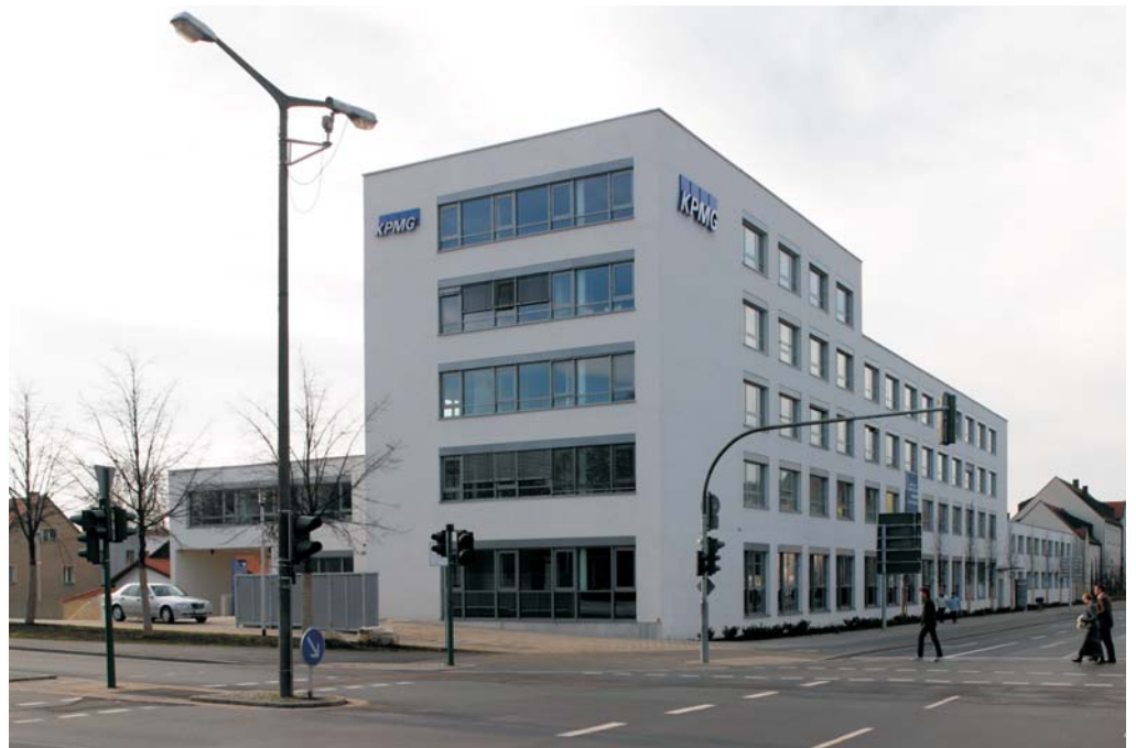
Frankenstraße 9 - Ansicht von Nordosten
