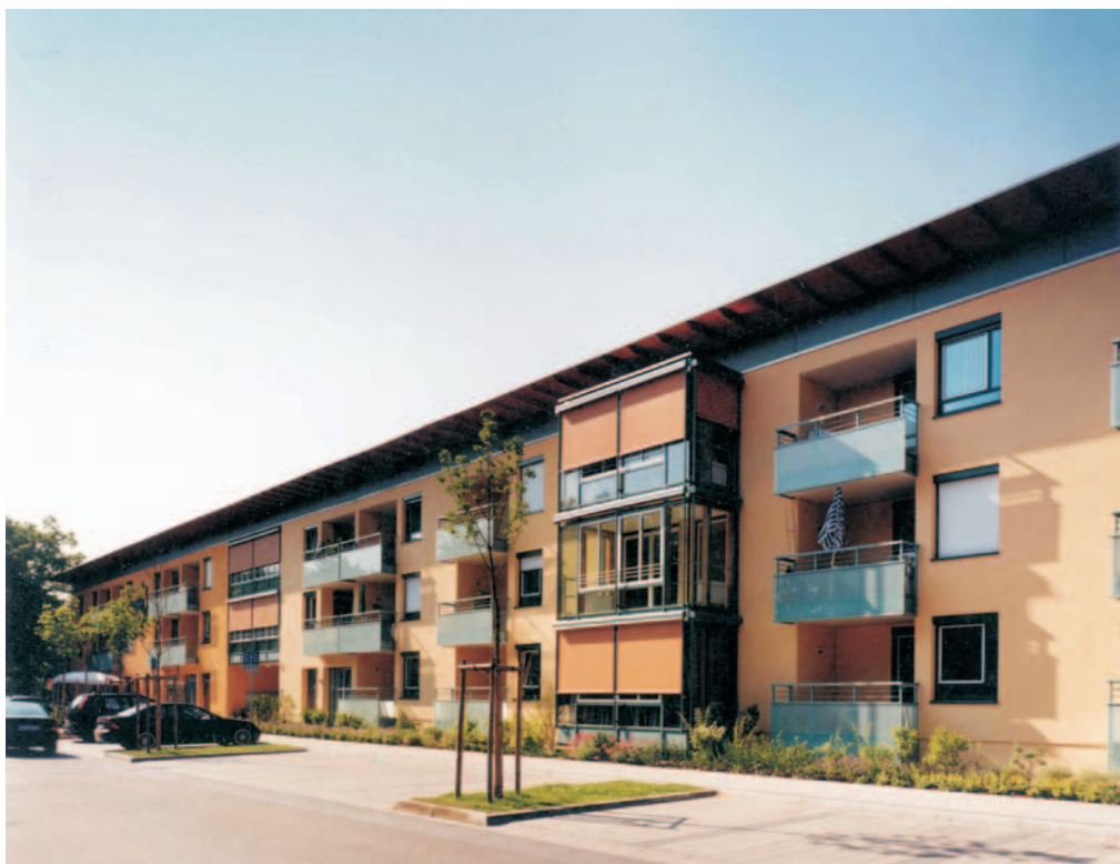
Udetstraße12/ Lilienthalstraße 58 - Ansicht von Süden
