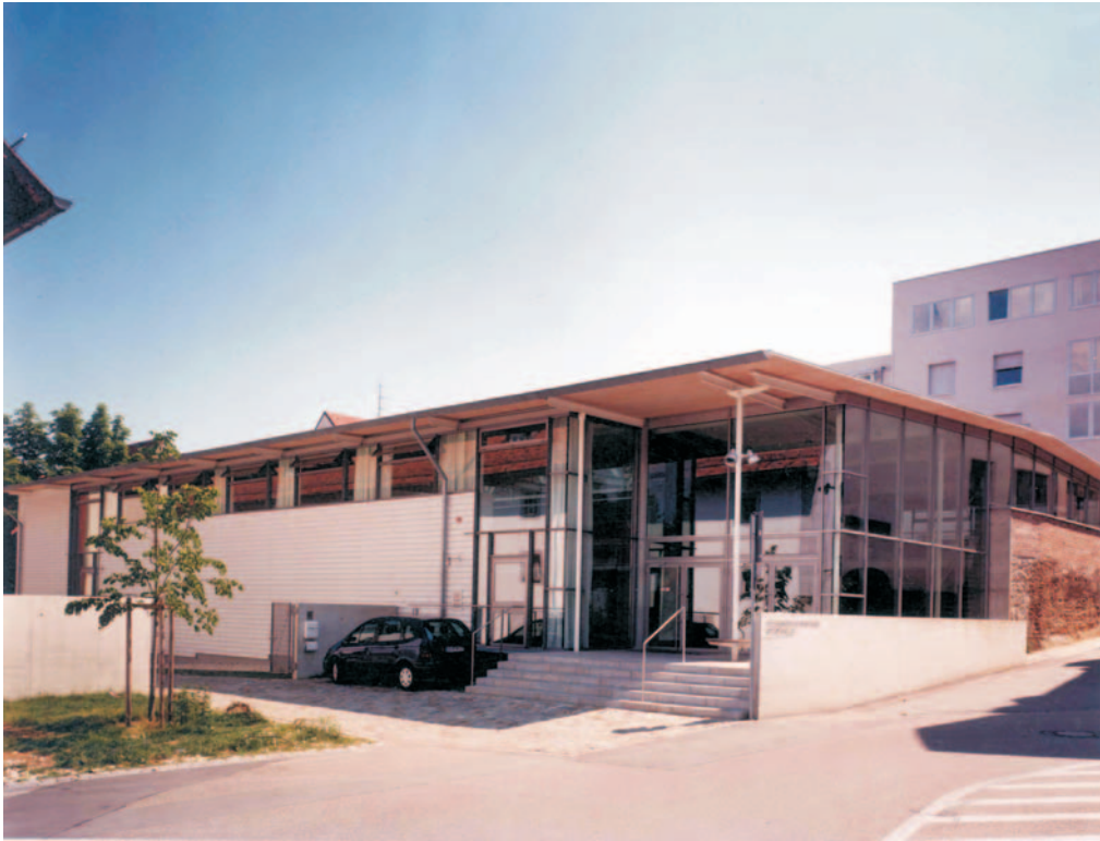
Gichtlgasse 1, 1a - Ansicht von Norden
