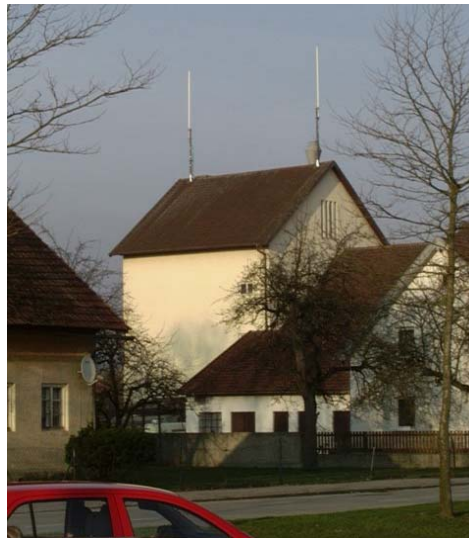
Abb. 1: Beispiel für eine Mobilfunksendeanlage mit omnidirektionalen Antennen.
