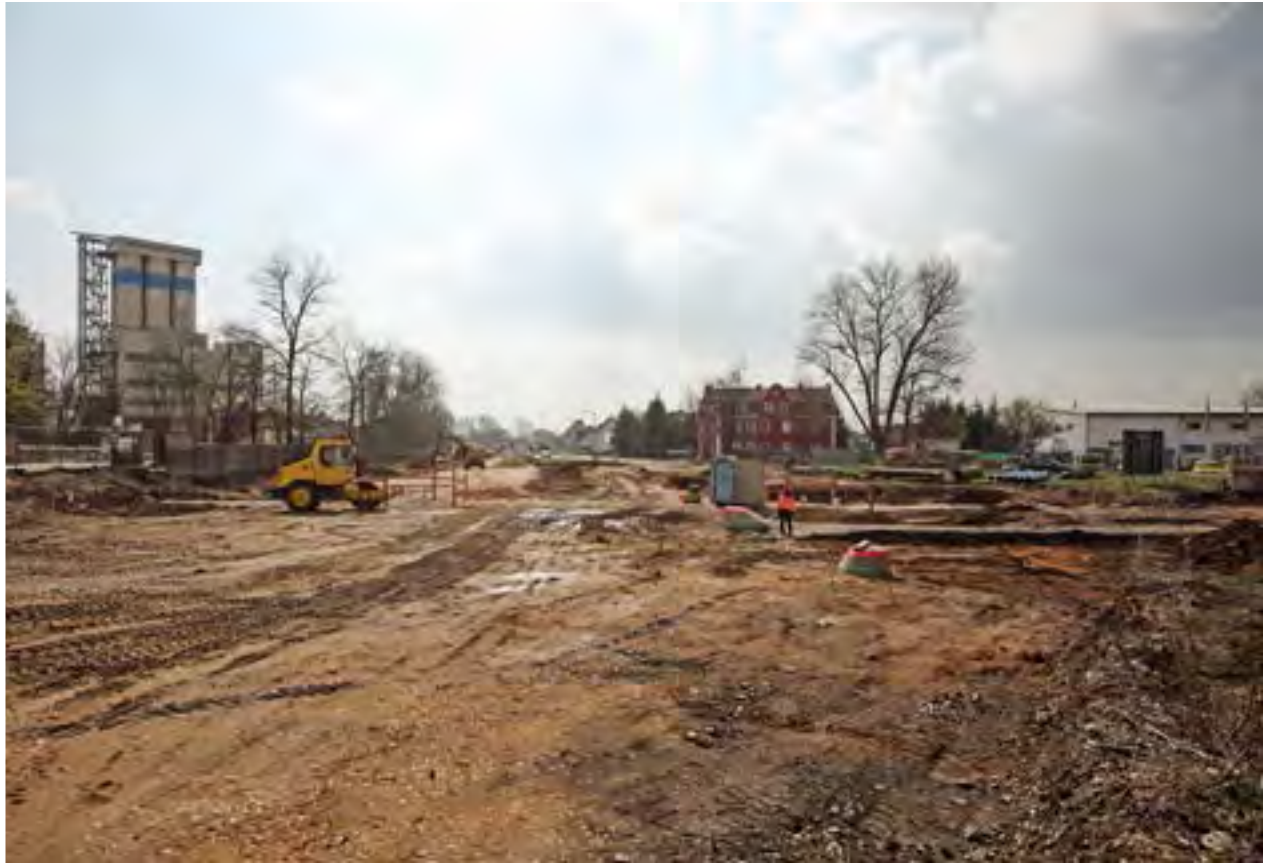
↑ Erdarbeiten Kreuzung Donaustauer Straße/Einfahrt Kalkwerk West
