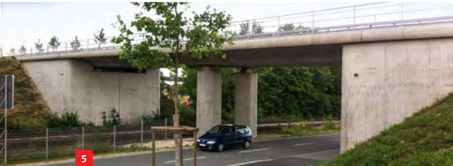
Brücke über die Bahnlinie Regensburg-Hof und über die Kreisstraße R 6 Beseitigung des höhengleichen Bahnübergangs in der Chamer Straße (2011/2012)
