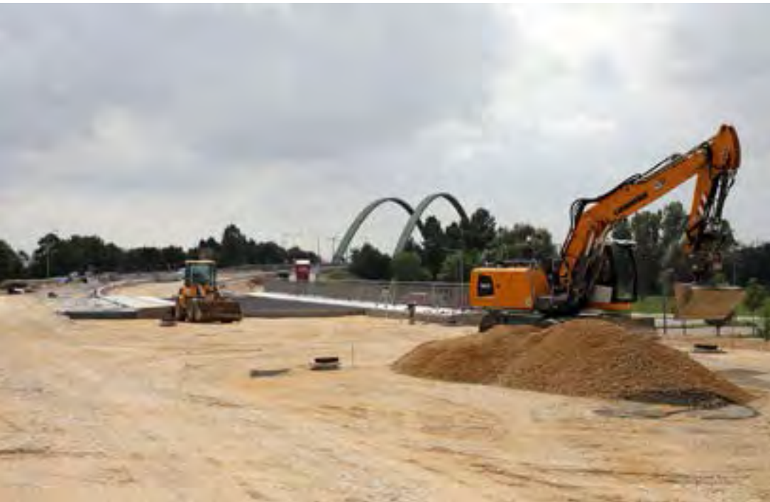
↓ Einbau der Frostschutzschicht auf der höher gelegten Walhalla-Allee
