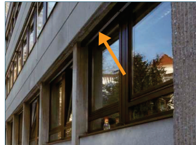
Abb. 3: Abendseglerquartier in einer Plattenfuge an einem Verwaltungsgebäude.
