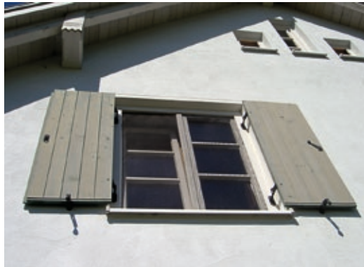
Abb. 26 (rechts): Nachdem die Fledermäuse weggezogen sind, kann der zurückgebliebene Kot mit einem Handfeger leicht entfernt werden.
