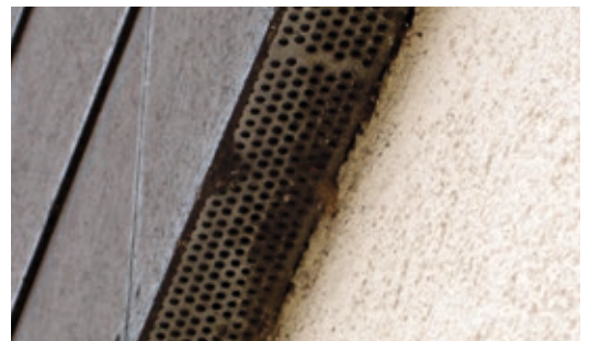
Abb. 27: Insektengitter an einem Flachdachabschluss.
