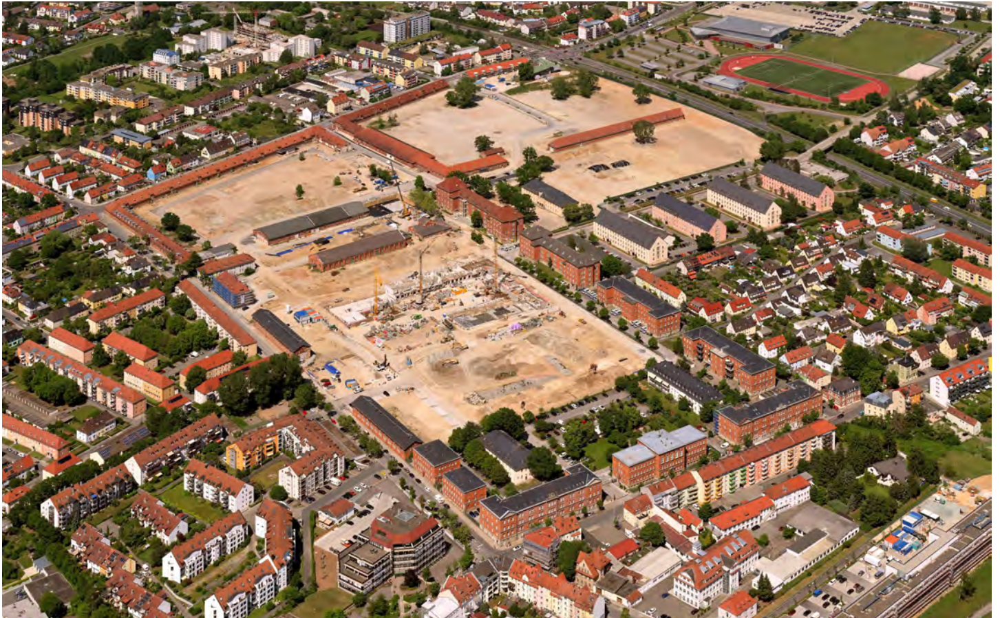
Stadtentwicklung in Quartiersdimensionen: Das 22,5 ha große Lagarde-Areal im Nordosten von Bamberg aus der Luft gesehen.
