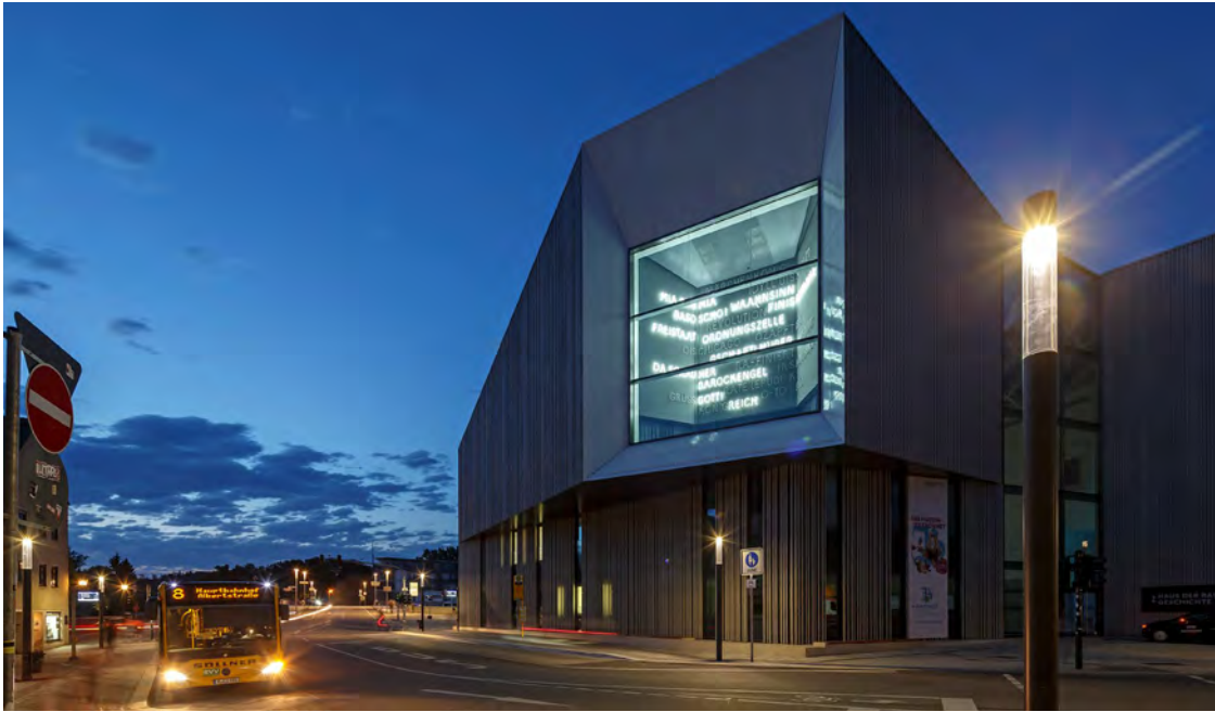
Das Haus der Bayerischen Geschichte wird vollständig mit Wärme und Kälte aus Abwasser klimatisiert.
