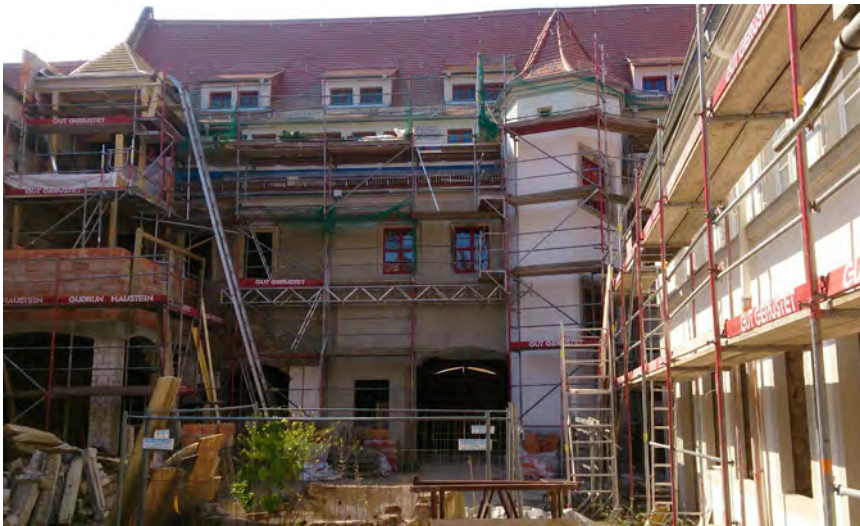
Hofansicht des Hauses Görnische Gasse 4 vor und während der denkmalgerechten Sanierung
