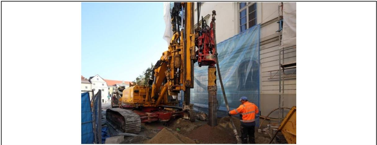
**Abbildung 39: Arbeiten am Entnahmeschacht für das Haus der Musik in Regensburg [46]**
