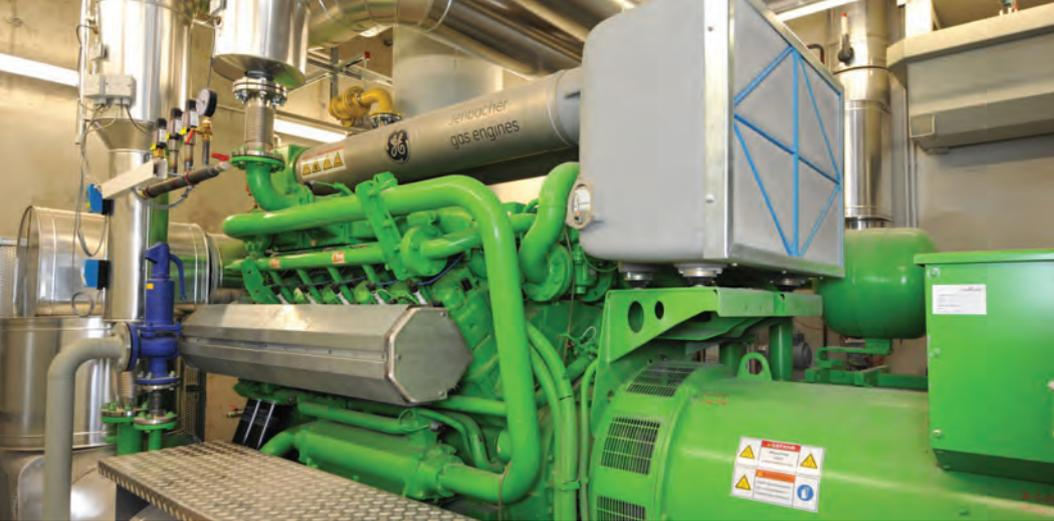
Heizanlage insgesamt: thermische Leistung 4.900 kW | prognostizierte Wärmemenge 7,2 Mio. kWh/a
