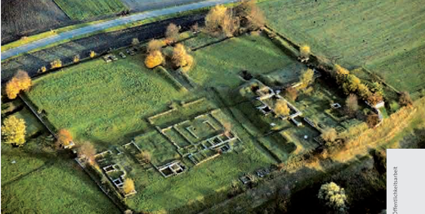
| Kastell Eining (Luftaufnahme)
