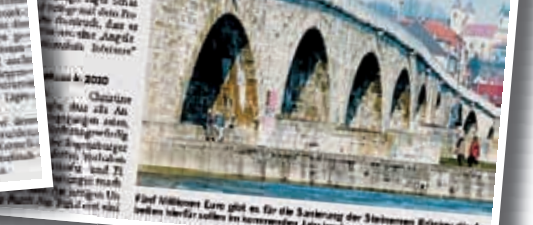
Die Steinernen Brücke in Regensburg ist ein Wahrzeichen der Stadt und wird derzeit saniert.
