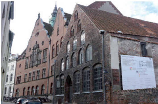
Sanierung des Kranenkonvents aus Mitteln des Investitionsprogramms Nationale Welterbestätten des Bundes, Hansestadt Lübeck
