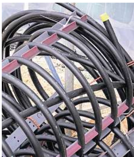
→ Mit einem stabilen Schlauch, in der Fachsprache: Erdkollektor, wird der Erde Wärme entzogen.
