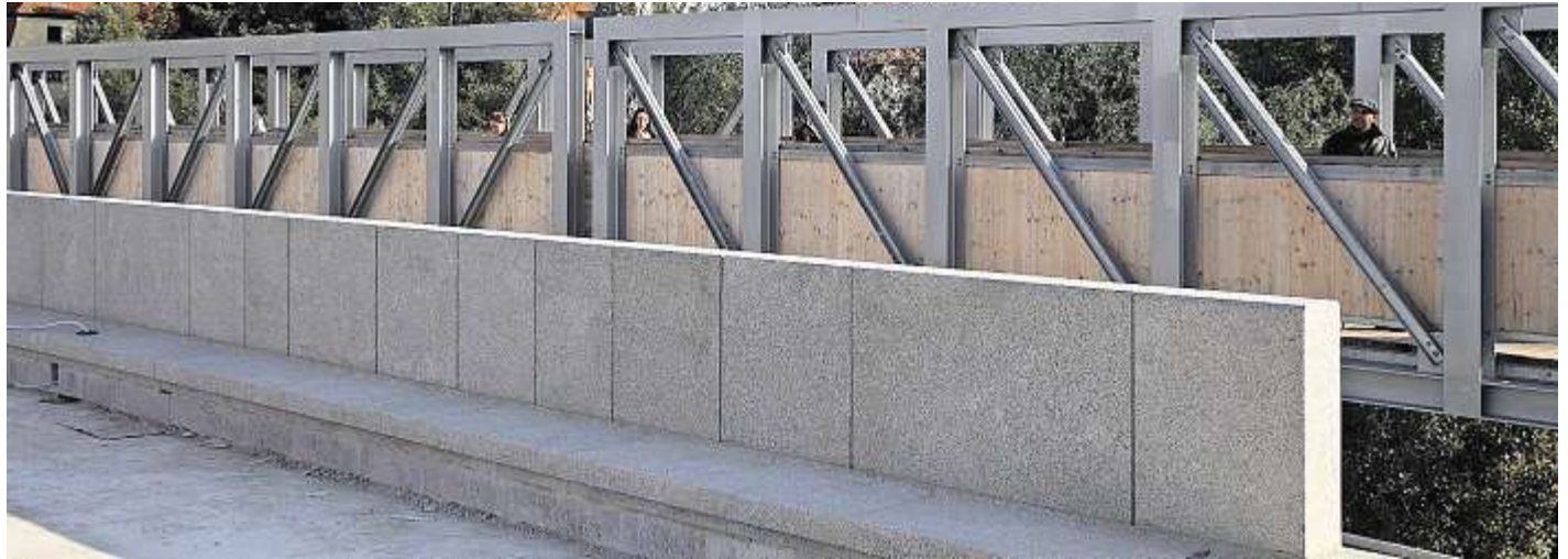
→ Für die Brüstung fiel die Wahl auf „Flossenbürger Granit gelb“. Die neue Brüstung ist einen Meter hoch und 30 Zentimeter breit.
