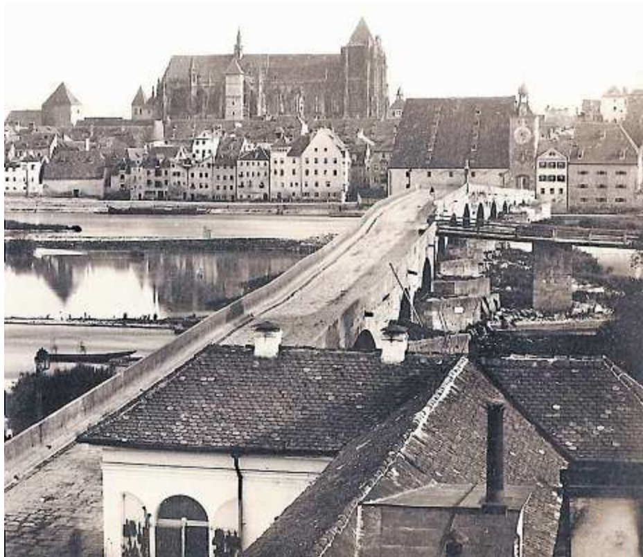
→ Um das Jahr 1860 bestand der Fahrbahnbelag der Steinernen Brücke noch aus Natursteinplatten. Bild: Historisches Museum Regensburg, um 1860
