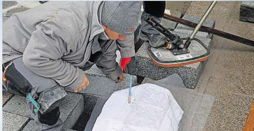
→ Auf dem Plan ist genau verzeichnet, wo welcher Stein eingebaut werden soll.
