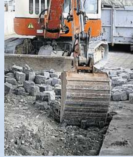
→ Das alte Kopfsteinpflaster wird durch massive Granitsteine ersetzt.
