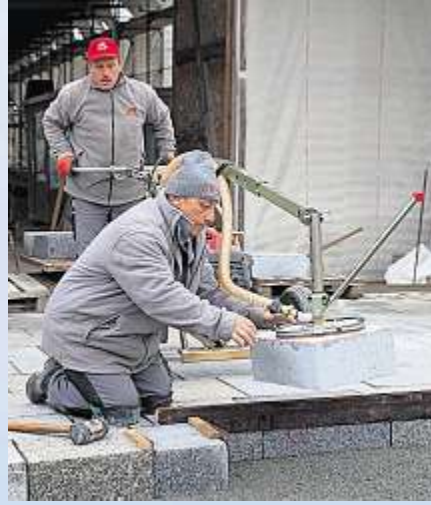
→ Das alte Kopfsteinpflaster wird durch massive Granitsteine ersetzt.
