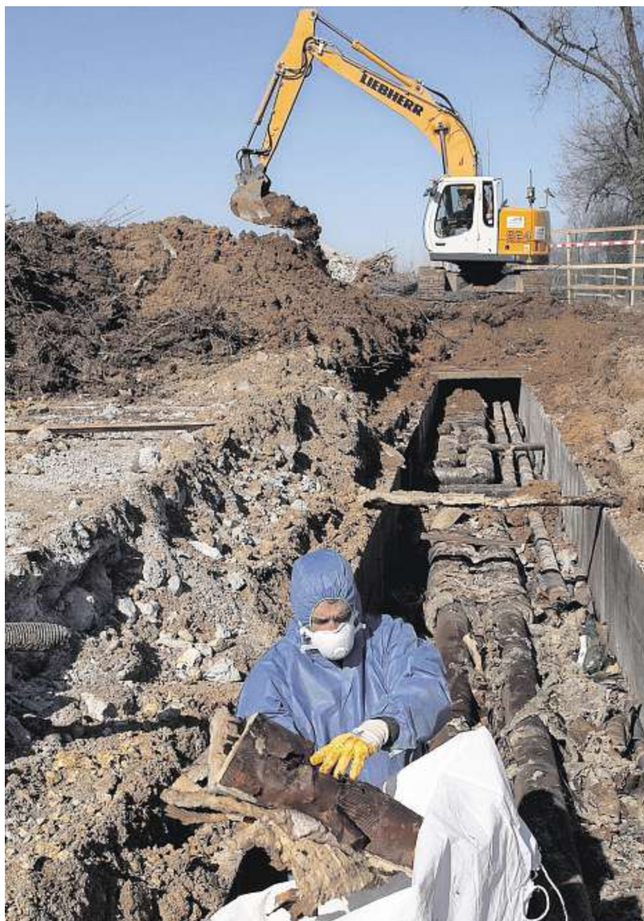
→ Experten entsorgen die mit asbesthaltigem Material isolierten Heizleitungen
