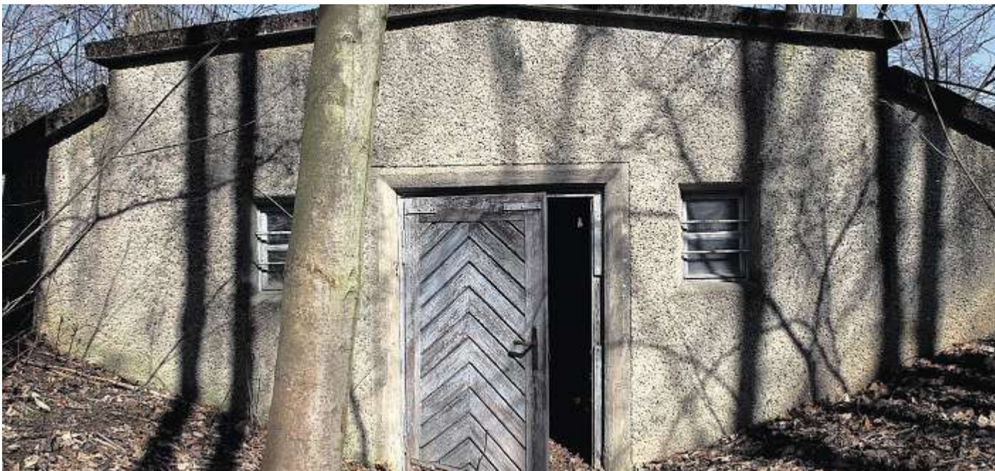
→ Die ehemalige Trinkwasserversorgungsanlage der US-Army wird künftig Fledermäusen ein Zuhause bieten
