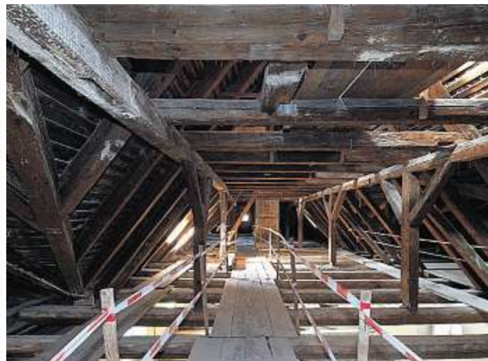
→ Mittlerweile sind die von der Denkmalpflege freigegebenen Einbauten aus dem 20. Jahrhundert zurückgebaut und die Holzbalken der Dach- und Deckenkonstruktionen für die anstehenden Sanierungsarbeiten freigelegt
