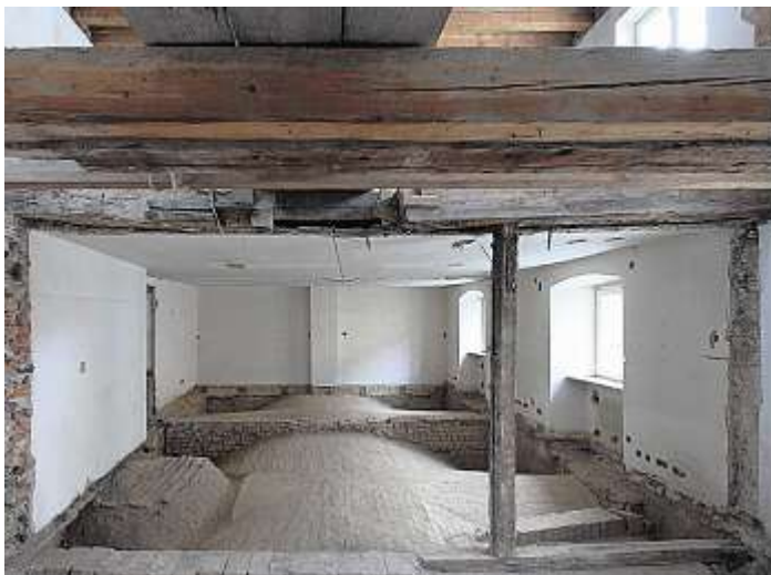
→ Mittlerweile sind die von der Denkmalpflege freigegebenen Einbauten aus dem 20. Jahrhundert zurückgebaut und die Holzbalken der Dach- und Deckenkonstruktionen für die anstehenden Sanierungsarbeiten freigelegt
