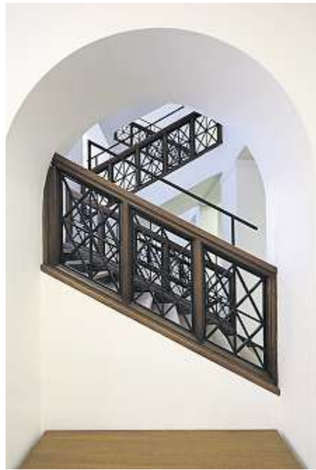
→ Der neue Handlauf nimmt ein Detail des ursprünglichen Geländers wieder auf.
