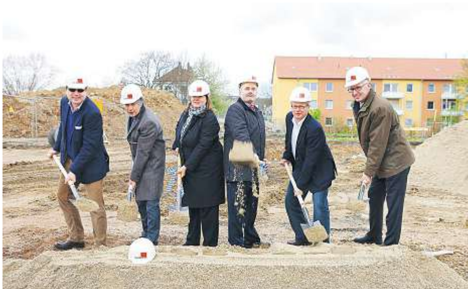
→ Spatenstich für das Projekt an der Daimler-/Guerickestraße
