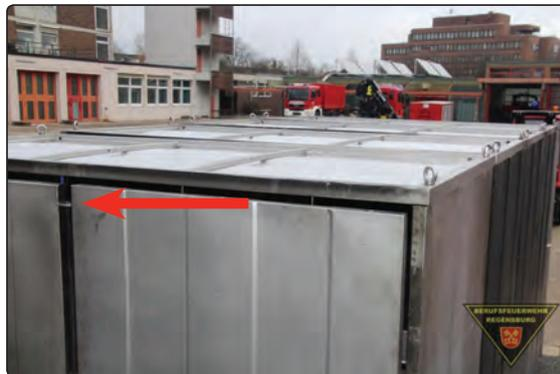
▶ Wandelemente für Rückseite (Element mit Öffnung für Flash-Over-Brenner beachten) mittig mit langer Verbindungsstange fixieren.
