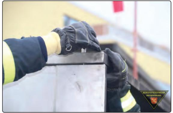
▶ Deckenelemente auf die seitlichen Wandelemente auflegen und ausrichten.
