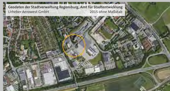
↓ Luftbild 10.04.01 Kreuzung Bushaltestelle Bajuwarenstraße/Schwabenstraße
