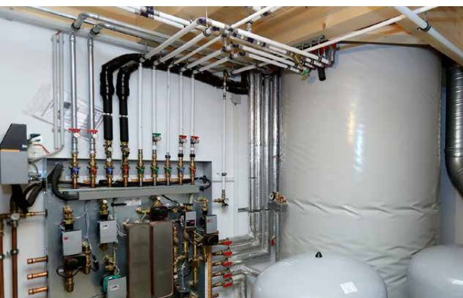
Alternative Wärmequellen konsequent nutzen
