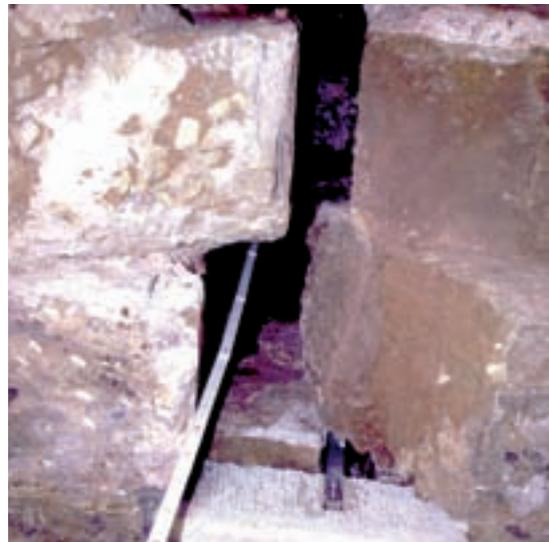
Abbildung 8: Spalten, Klüfte im Mauerwerksgefüge
