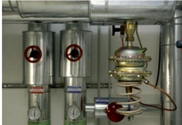
Abbildung 3: Drucksteuerung der Heizungsumwälzpumpen
