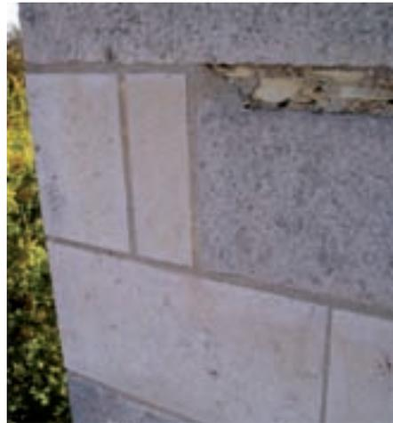
Abbildung 8: Steinaustausch im Bereich der Eckquaderung
