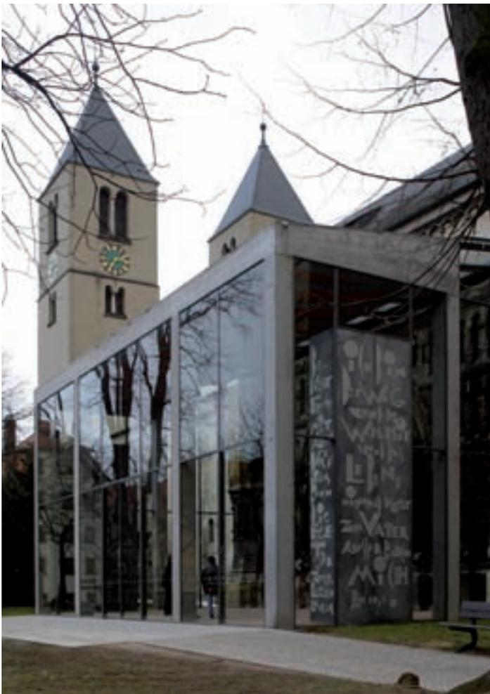
Abbildung 10: Das Schottenportal mit Schutzeinhausung in Glas-Stahl-Betonkonstruktion im Jahr 2000
