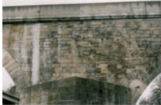
Abbildung 4: Geschädigtes Mauerwerk an den Stirnwänden
