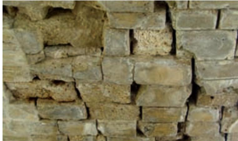
Abbildung 17: Freigelegtes Mauerwerk mit Fugen am Musterbogen XIV
