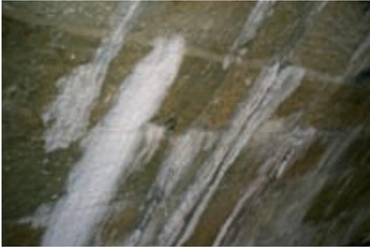
Abbildung 3: Aussinterungen an den Bogenuntersichten
