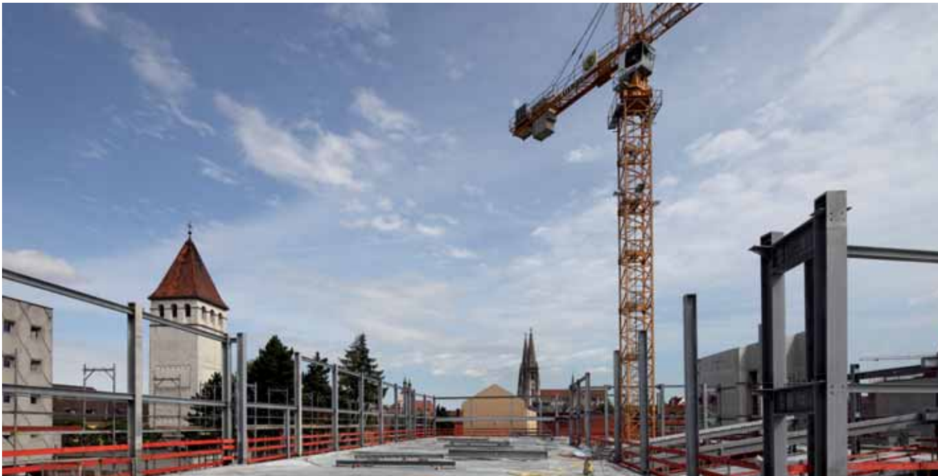
Baustelle des Parkhauses: Im November 2013 sollen die Rohbauarbeiten abgeschlossen werden
