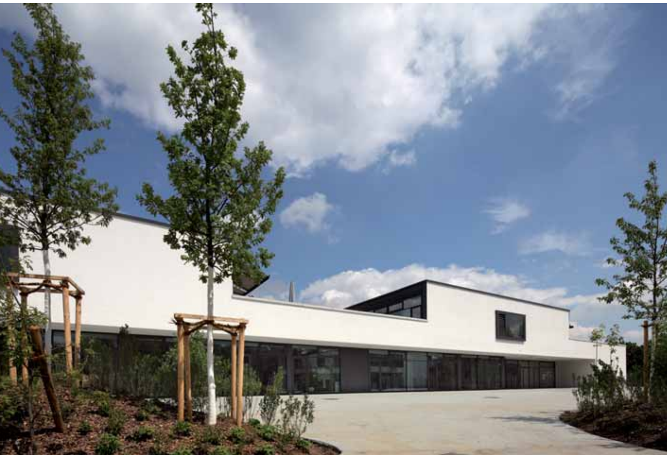
Eingangsbereich der Grundschule Prüfening
