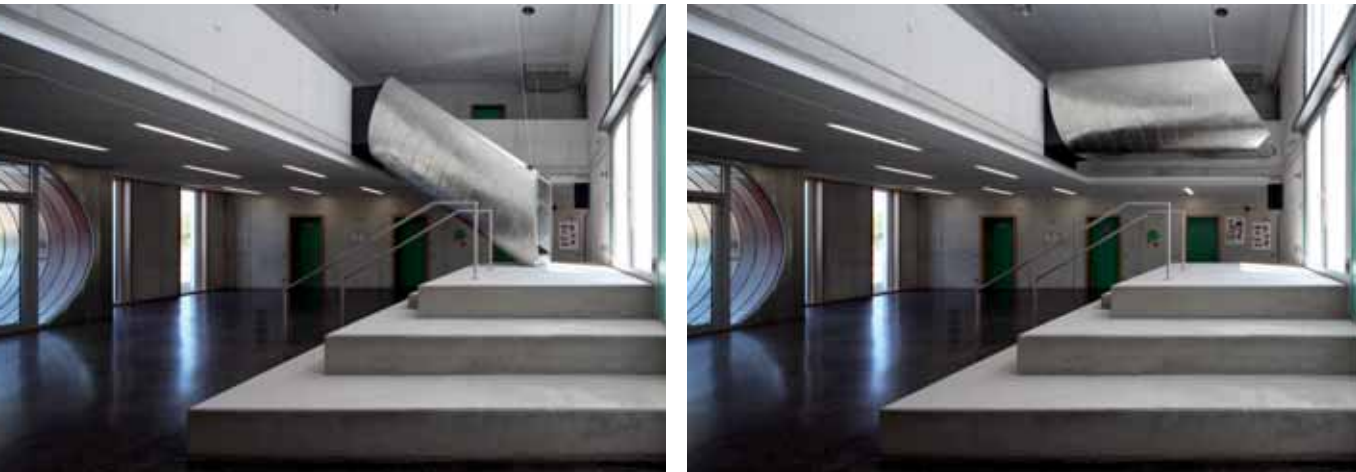
Zugtreppe unten und schwebend
