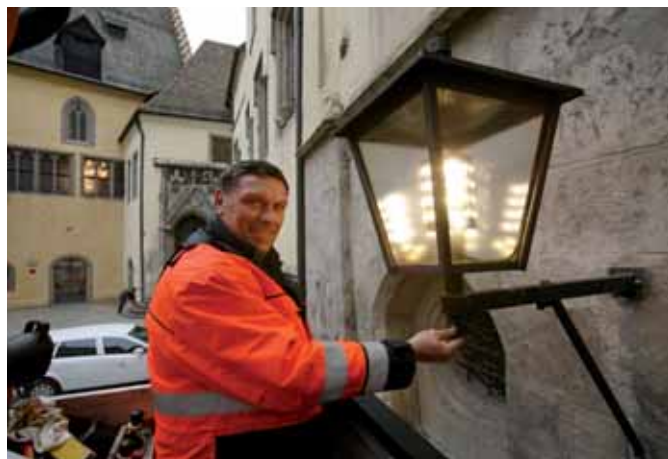
Einsetzen der LED-Retrofits und Montage und Funktionskontrolle vor Ort
