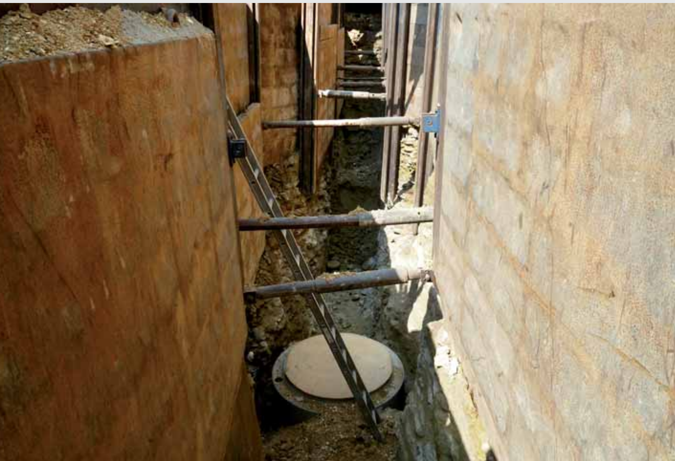
Blick in die Kanalbaustelle Simmernstraße
