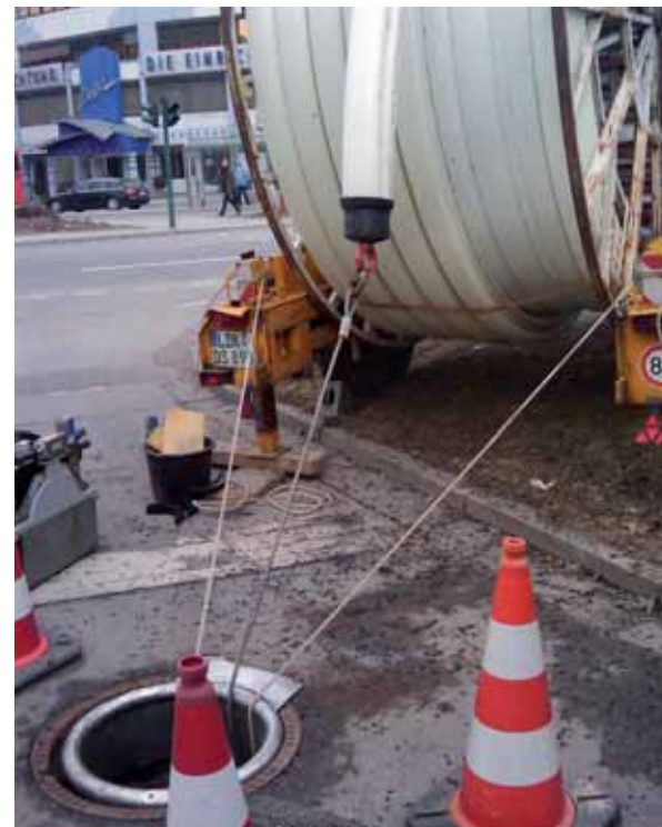
Close-Fit Sanierung (Rohrsanierung mit Rohren aus thermoplastischen Kunststoffen)
