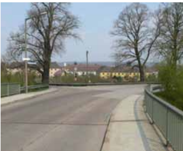
Dechbettener Brücke Richtung Margaretenau
