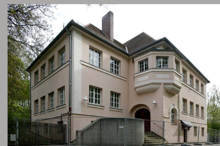
ANSICHT ALTER HAUPTINGANG SÜD - WEST
