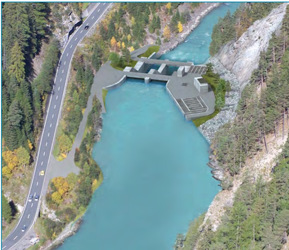
Wasserkraftwerk von oben
