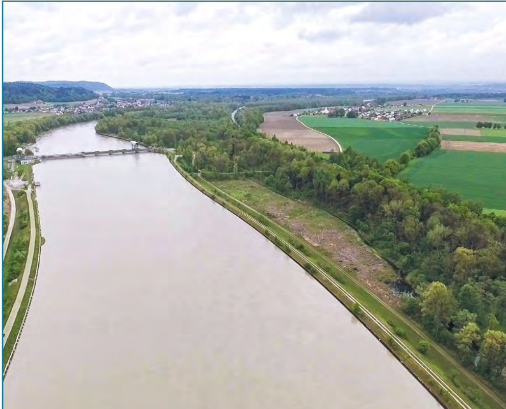
Begradigter Abschnitt des Inns
