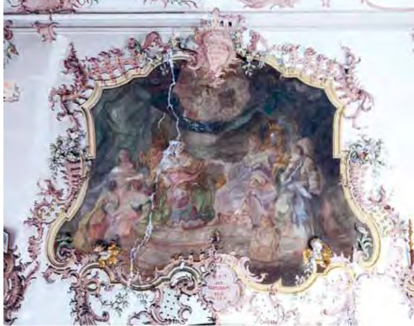
▲ Musterachse zur Restaurierung der Wandmalerei. Die rechte Bildhälfte zeigt den geplanten Zustand nach der Restaurierung
