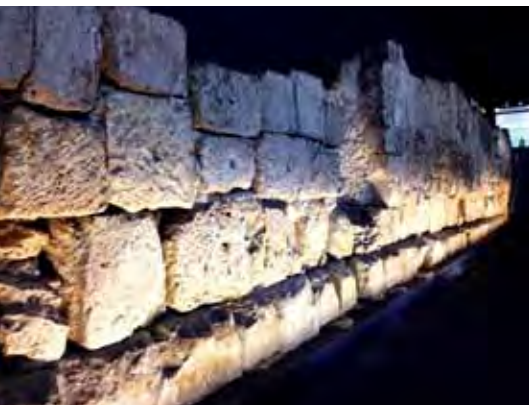
▲ Blick auf die sanierte Römermauer im Untergeschoss des Parkhauses
