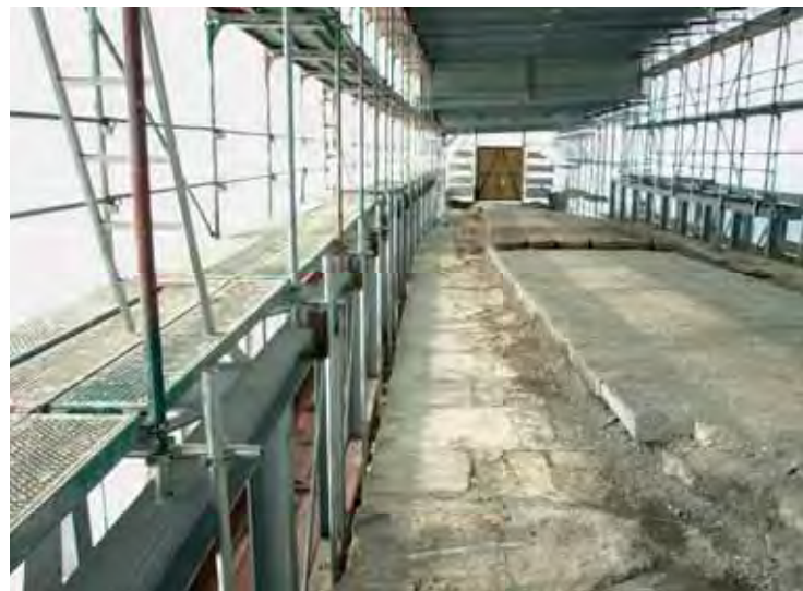
▲ Brückenseite nach dem Rückbau der Brüstungen und des Belags
