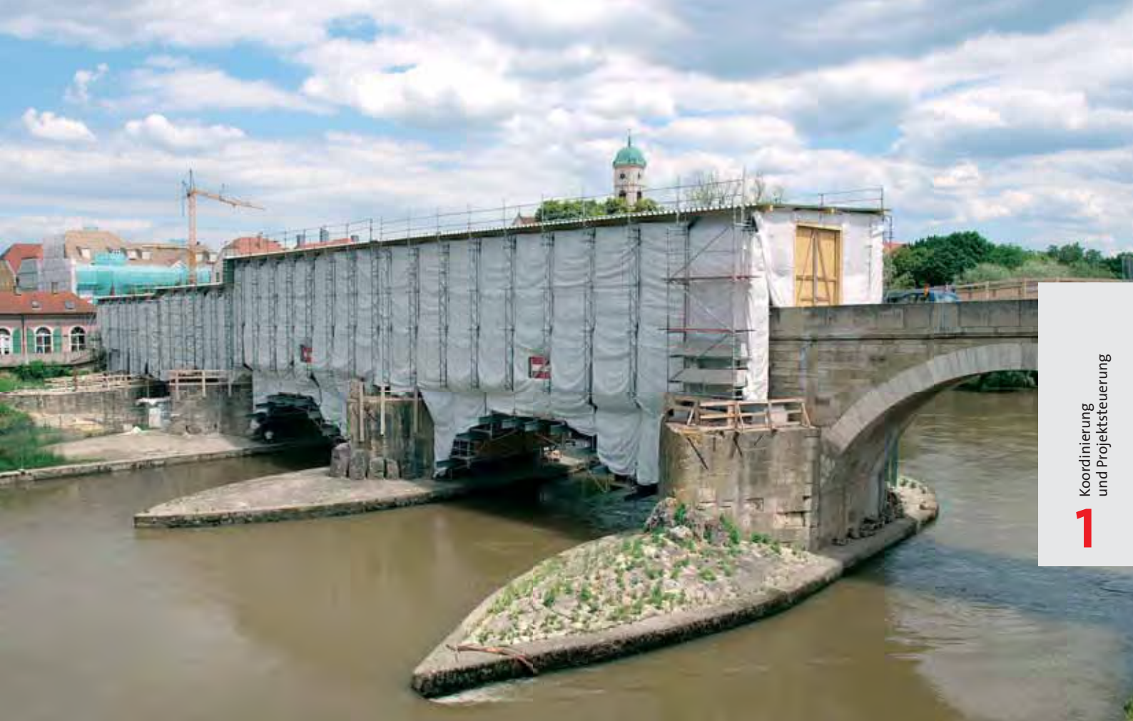
▲ Ansicht Einhausung vom Bauabschnitt I von Westen
